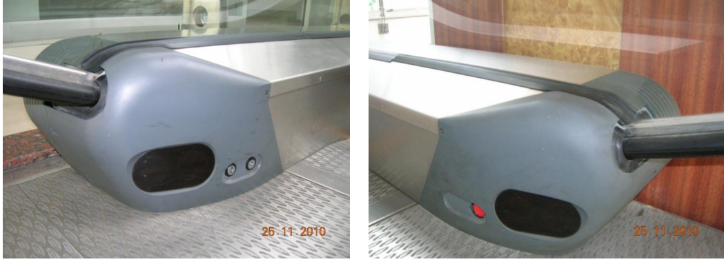
Şekil 4.28: Acil durdurma anahtarları.
