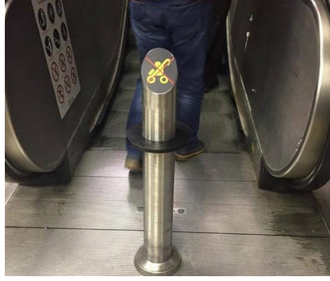
Şekil 4.38: Yürüyen merdiven biniş engeli [34].
