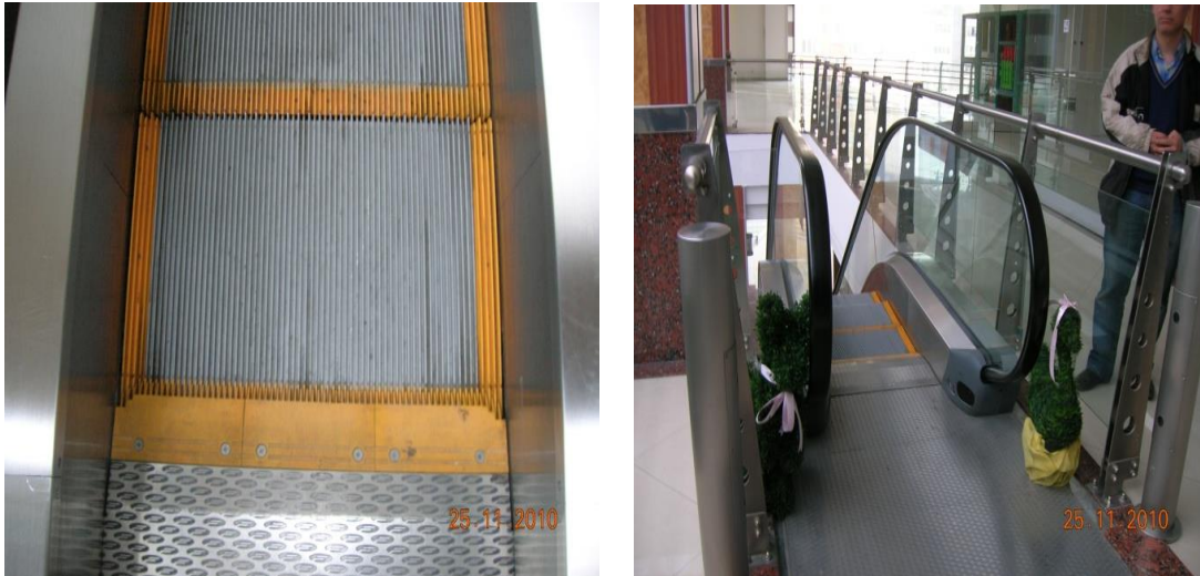
Şekil 4.27: Tarak dişleri.
