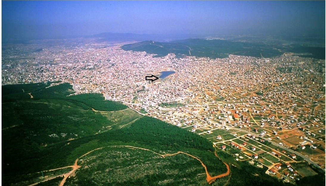
Şekil 3.5 : Ömerli Havzası, Sultanbeyli'nin TEM otoyolu sonrası havadan fotoğrafı (2008)
