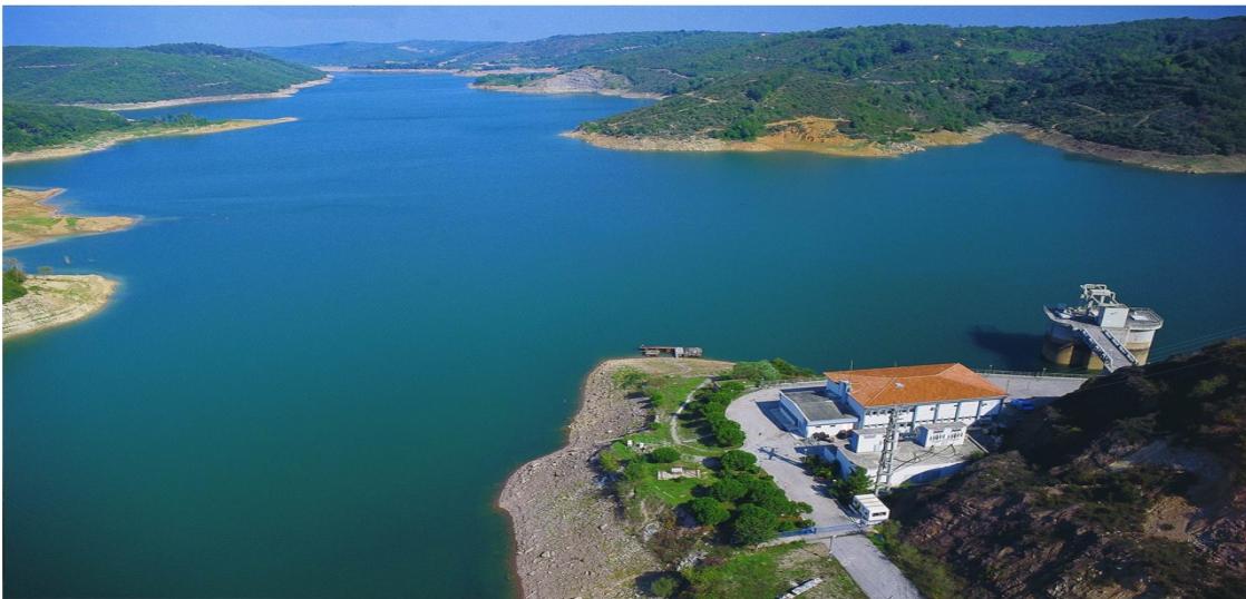
Şekil 4.27 : Darlık Baraj Gölü, Su Alma Yapısı ve Pompa İstasyonu (İSKİ, 2016).
