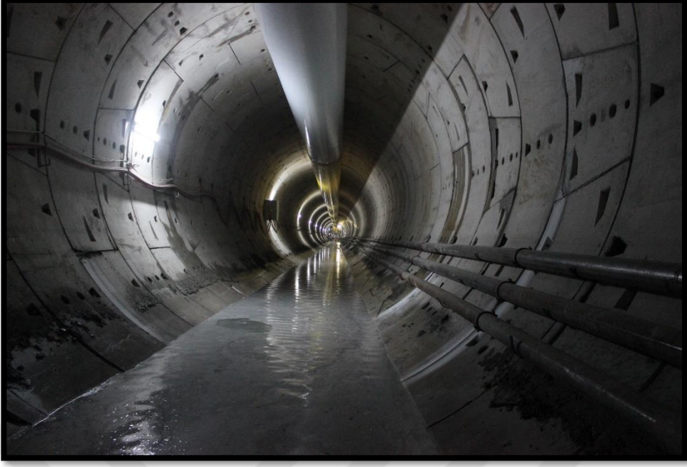
Şekil 5.39. Tünele gelen su girişi
