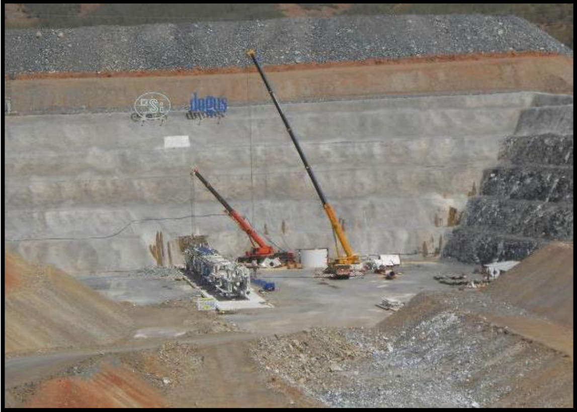
Şekil 5.2. Tünel çıkış / TBM giriş portalı
