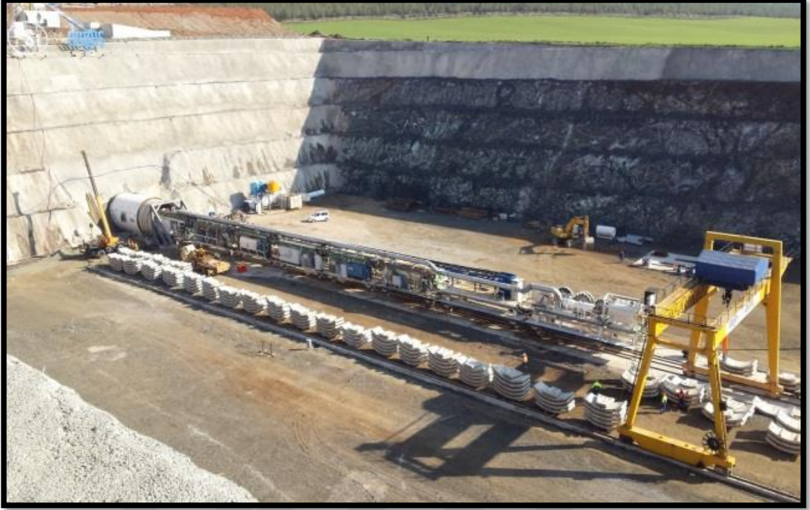
Şekil 5.12. Projede kullanılan EPB/TBM
