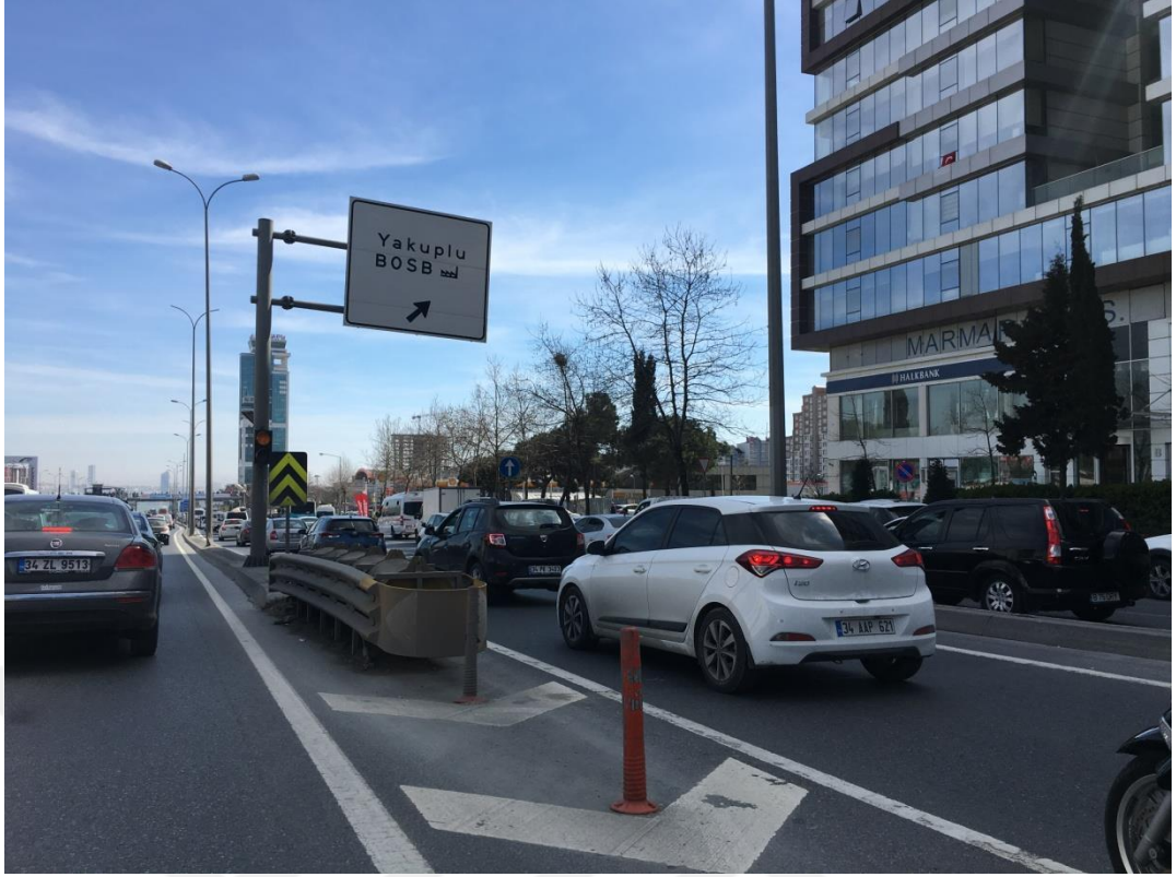
Şekil 4.3 : E-5 Karayolu Beylikdüzü Avcılar istikameti Yakuplu-Beylikdüzü Organize Sanayi Bölgesi ayırımında kullanılan Tau P-80 tipi çarpma yastığı.
