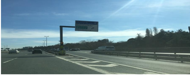
Şekil 4.15 : Çarpma yastığı eksikliği Zincirlikuyu istikameti Mahmutbey çıkışı.
