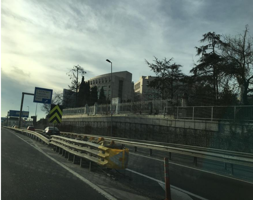
Şekil 4.4 : Zincirlikuyu-Edirnekapı İstikameti Çağlayan Taksim Ayrımı Adalet Sarayı Önünde kullanılan Tau P-100 tipi çarpma yastığı kullanımı.
