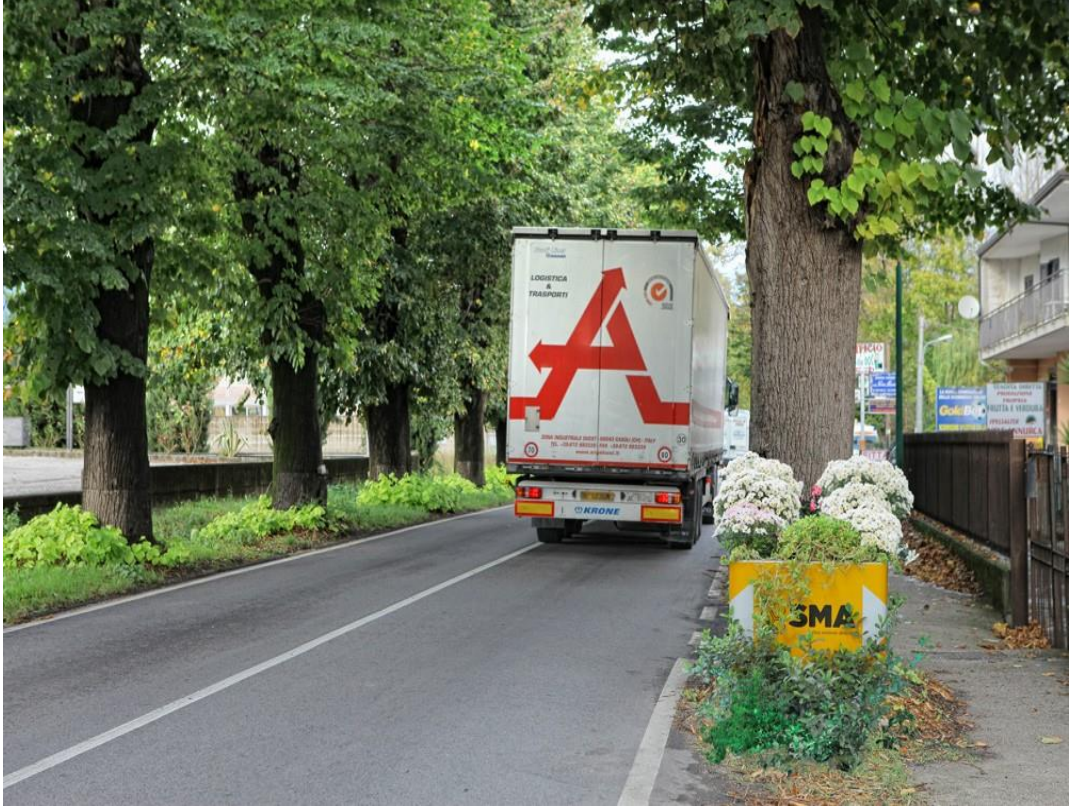
Şekil 5.3 : SMA Firması Ağaç Çarpma Yastığı [21].
