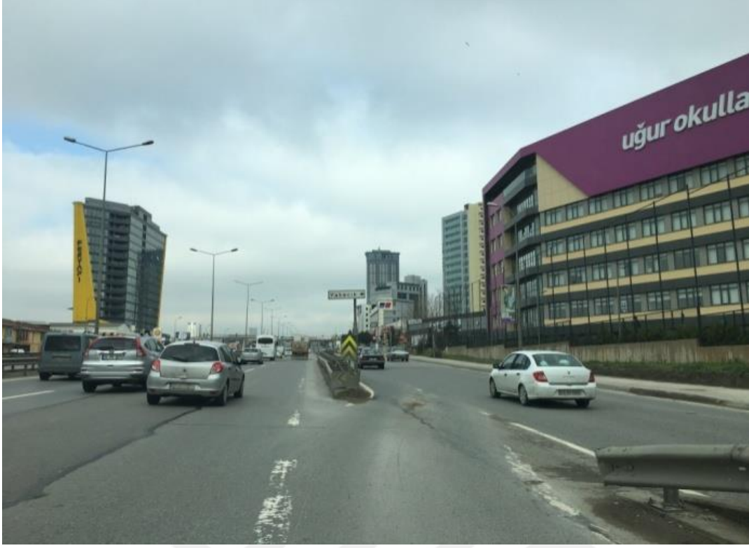
Şekil 2.2 : İstanbul'da önlem alınmadan yeterince korunamayan yol ayrımı Kartal Yakacık Mevkii.
