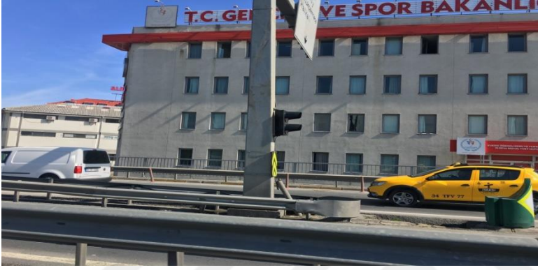
Şekil 4.14 : Çarpma yastığı eksikliği Zincirlikuyu istikameti Florya girişi.
