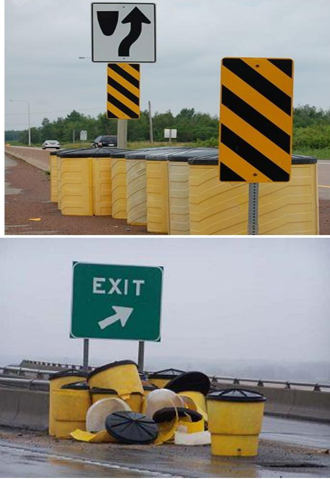
Şekil 2.8 : İlk kez 1955 yılında John Fitch tarafından geliştirilmiş kum dolu varillerden oluşan Fitch çarpma yastığının günümüzde kullanımı [7].
