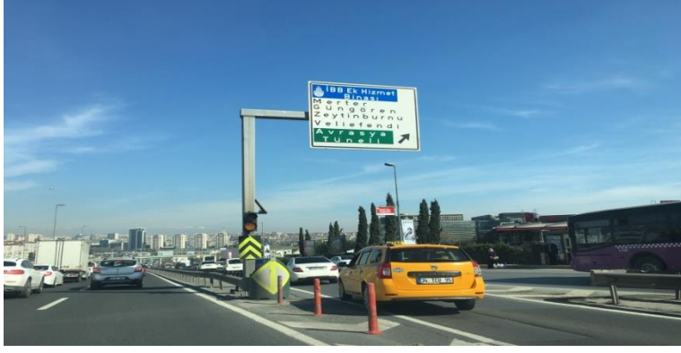
Şekil 4.20 : Çarpma yastığı eksikliği Zincirlikuyu istikameti Veliefendi çıkışı.
