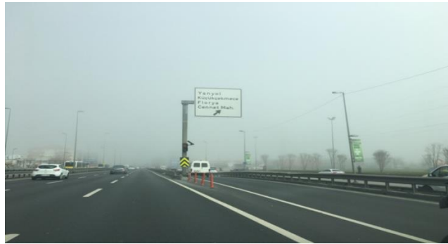
Şekil 4.12 : Çarpma yastığı eksikliği Zincirlikuyu istikameti Küçükçekmece çıkışı.
