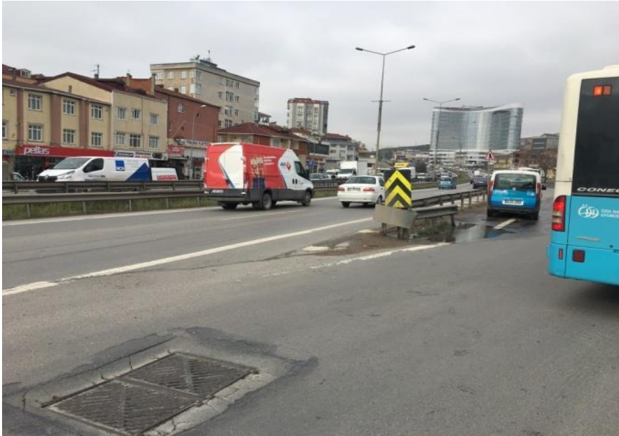
Şekil 2.1 : İstanbul’da önlem alınmadan yeterince korunamayan yol ayrımı Pendik Kaynarca durağı önü.
