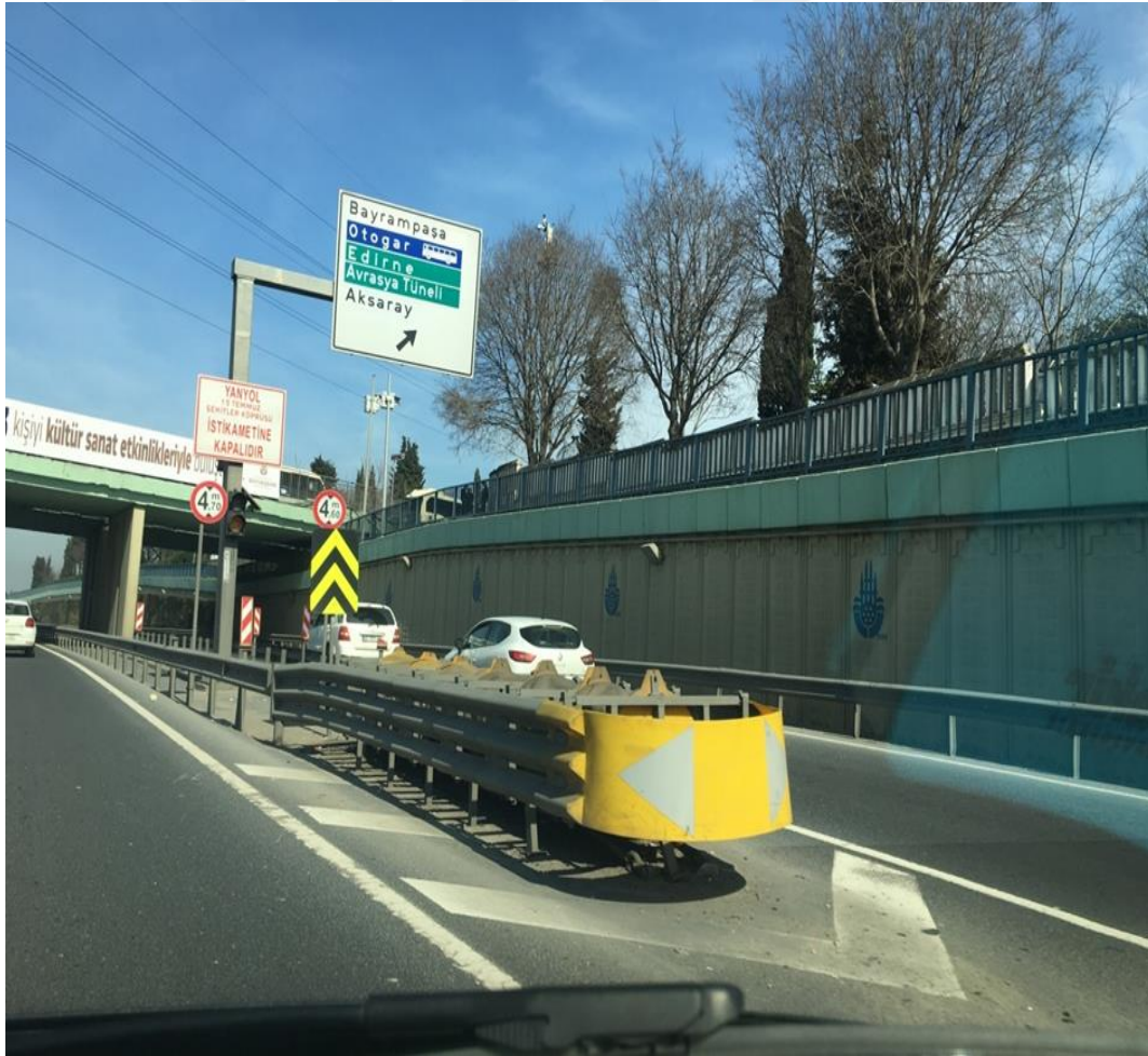
Şekil 4.5 : Topkapı-Okmeydanı İstikameti Aksaray Bayrampaşa Yan Yol Ayrımında kullanılan Tau M-80 tipi çarpma yastığının kullanımı.
