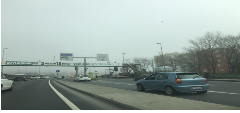
Şekil 4.13 : Çarpma yastığı eksikliği Zincirlikuyu istikameti Küçükçekmece girişi.
