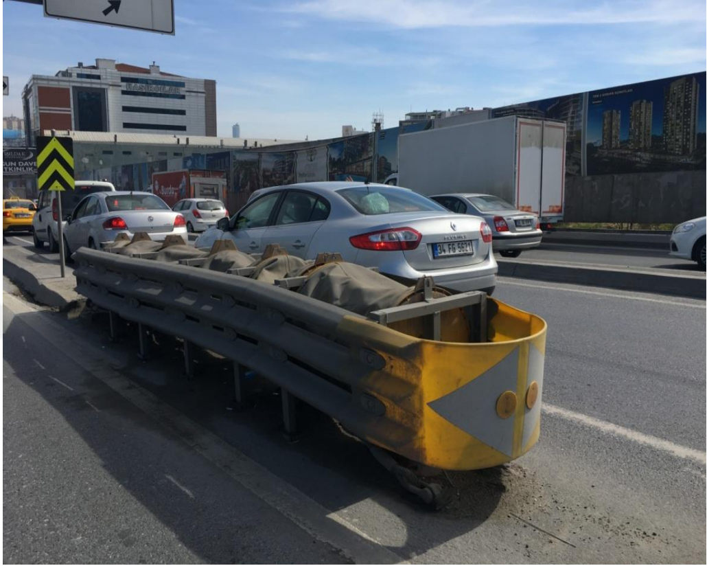
Şekil 2.6 : İstanbul'da D100 karayolunda refüje araç girmesini önlemek için kullanılan ithal çarpma yastığı.
