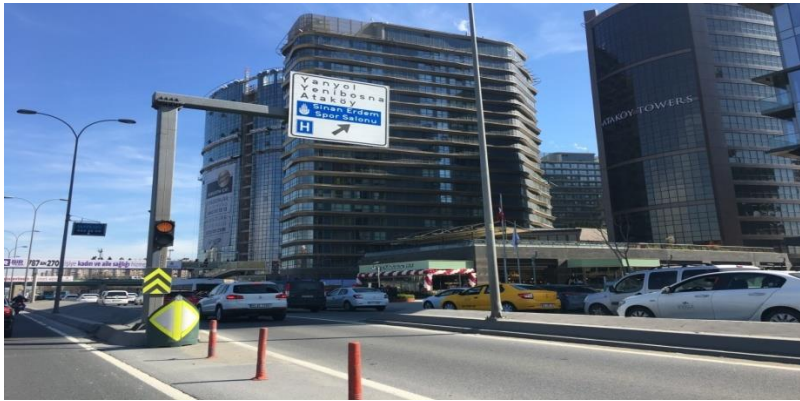
Şekil 4.16 : Çarpma yastığı eksikliği Zincirlikuyu istikameti Ataköy ayrımı.
