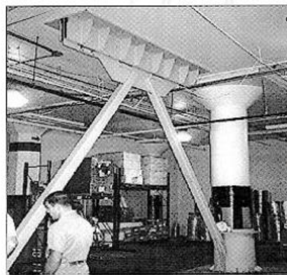
Şekil 3. 14: Viskoelastik sönümleyiciler için örnek yapılar.
