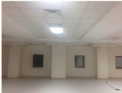
Şekil 6. 20: İzolatör kapatılması detayı.
