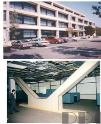
Şekil 3. 14: Viskoelastik sönümleyiciler için örnek yapılar.
