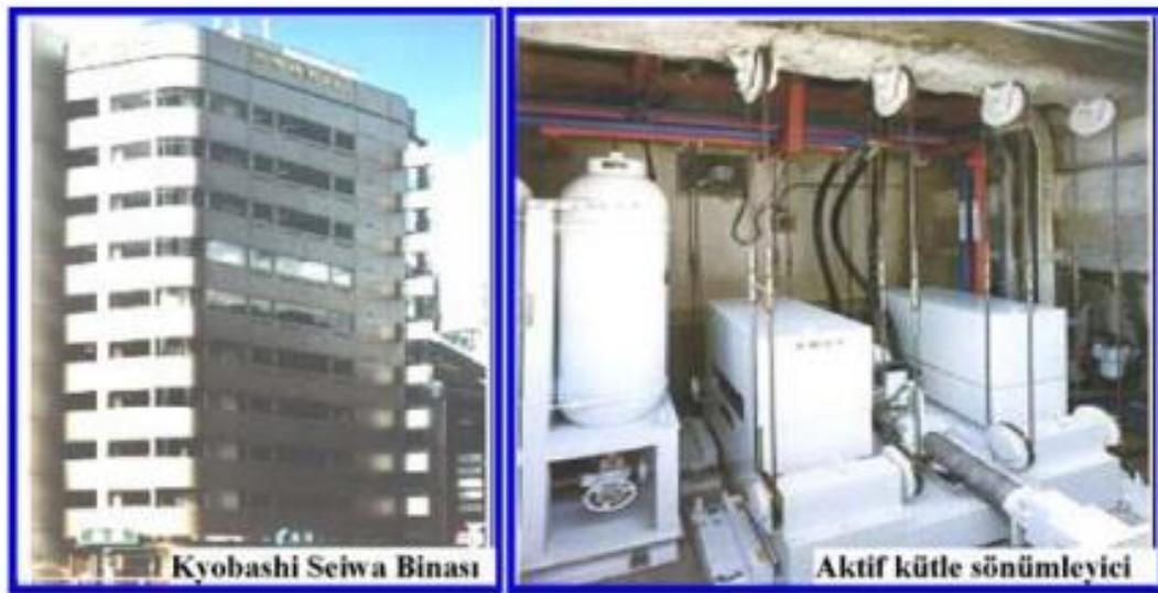
Şekil 3. 6: Aktif kütle sönümleyici sistem uygulaması.
