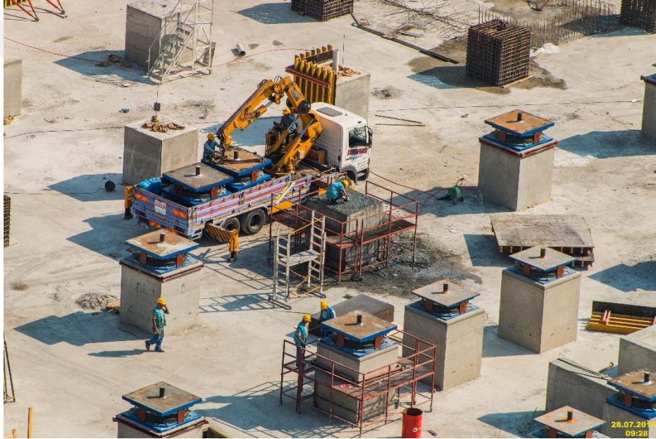
řekil 6. 12: Kullanılan izolatör tipi 3'li sirtünmeli sarkaç sistem ve montajı.
