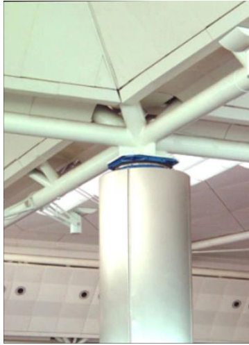
řekil 4. 22: Atatrk Havalimanı çatısında kullanılan srtnmeli sarkaç mesnet detayı.
