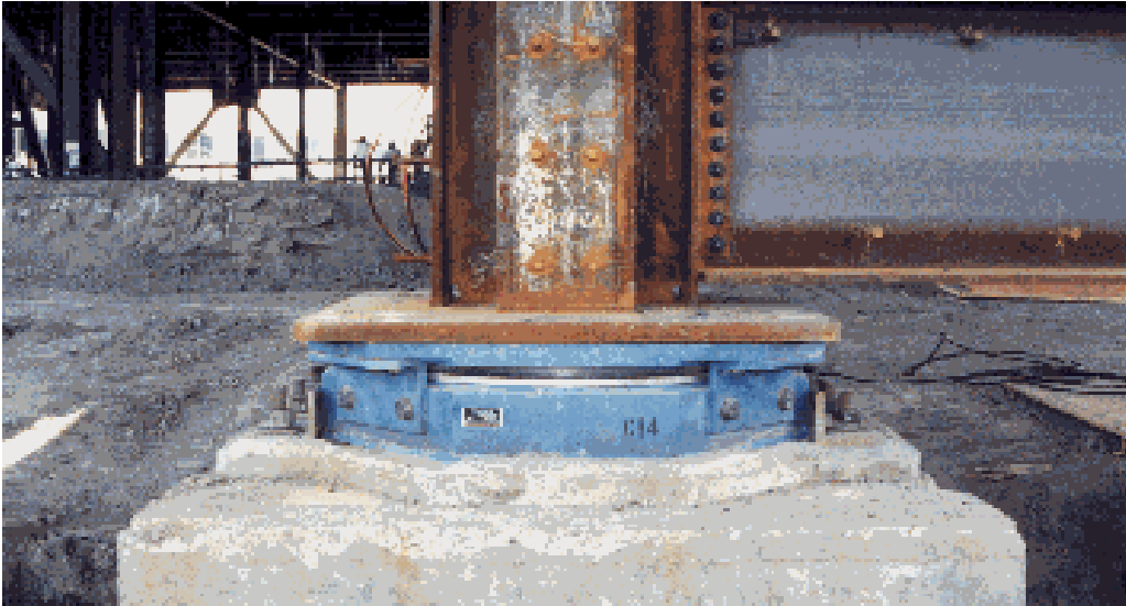
Şekil 4. 7: Havalimanı srtnmeli sarkaç izolatr.
