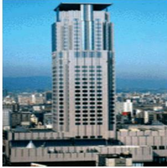
Şekil 3. 3: En üst katta AMD bulunan Applause Kulesi, Japonya.
