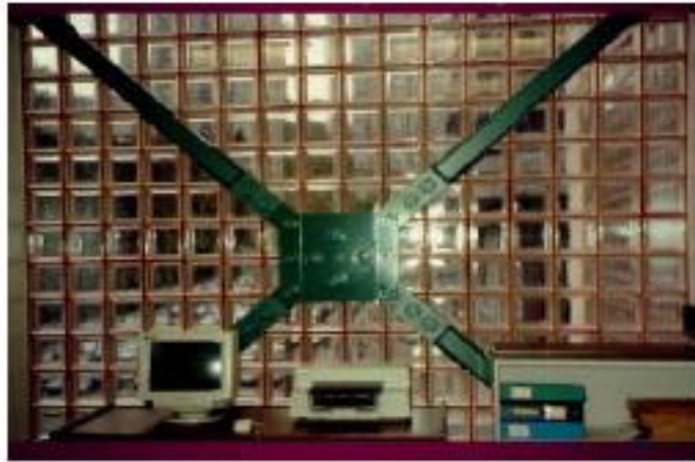
Şekil 3. 11: Sürtünmeli sönümleyici yerleşimi.
