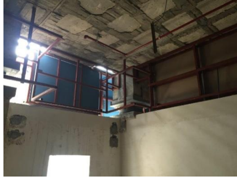
Şekil 6. 21: Bina cephesindeki sismik boşluğun kapatılması detayı.
