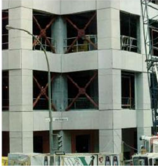
Şekil 3. 12: Sürtünmeli sönümleyici X tipi yerleşimi.
