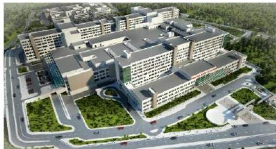
Şekil 4. 27: Eskişehir Şehir Hastanesi genel görünüş.
