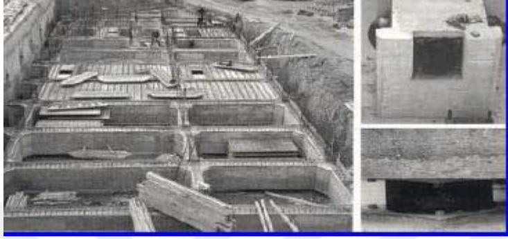
Şekil 4. 14: Yüksek sönümleyici kauçuk mesnet ile temel inşaatı, 1998.
