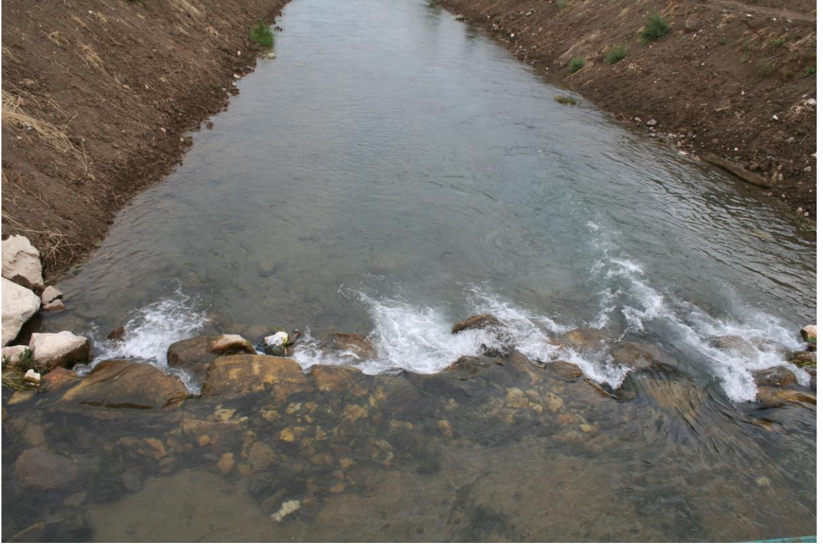
Şekil 3.8. Üstünler Köprüsü Beyşehir Göl girişi
