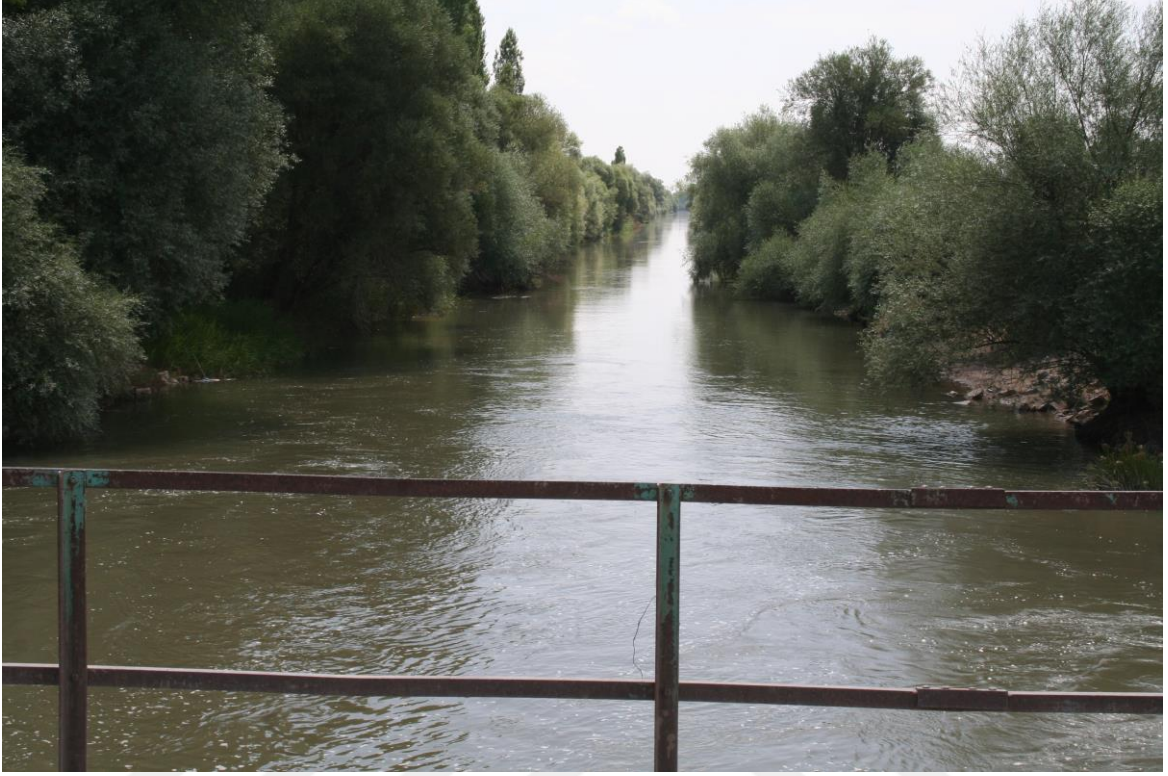
Şekil 3.12. BSA Kanalı Kumluca Köprüsü Suğla girişi
