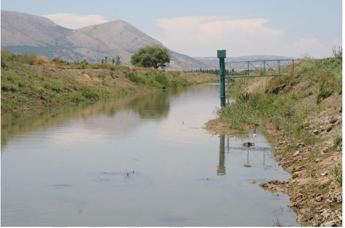
Şekil 3.9. Soğuksu Yeşildağ Köprü 1 Beyşehir Göl girişi
