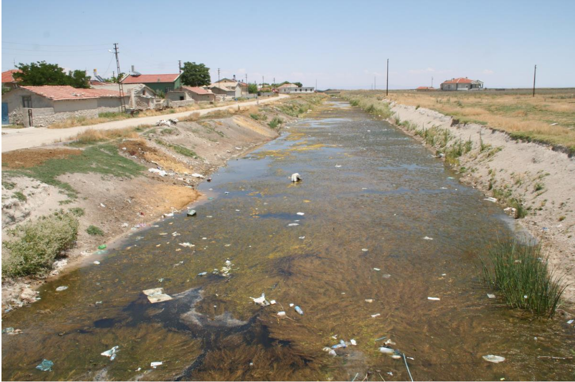
Şekil 3.16. Apa Tahliye Kanalı – Gölyazı Köprüsü
