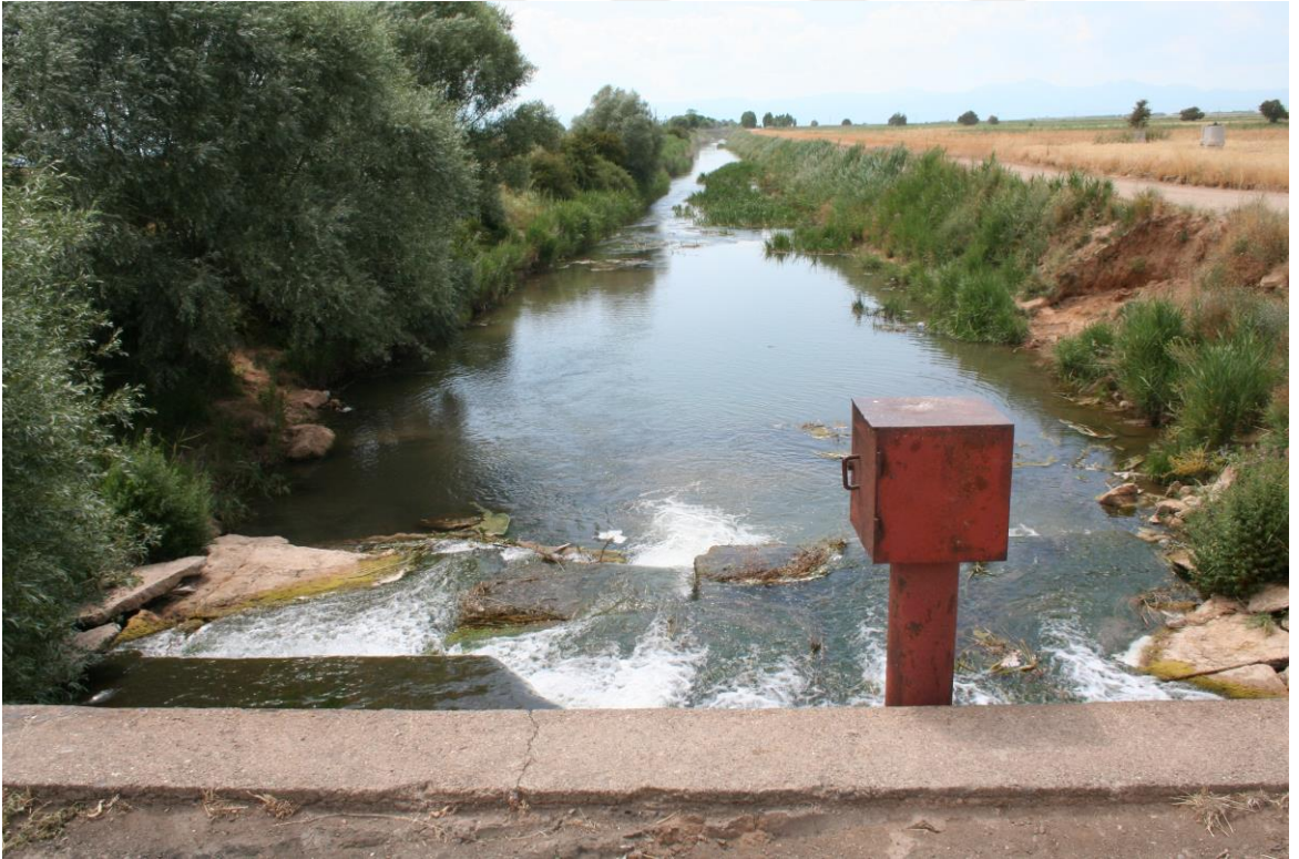
Şekil 3.10. Çeltik Kanalı Beyşehir Göl girişi
