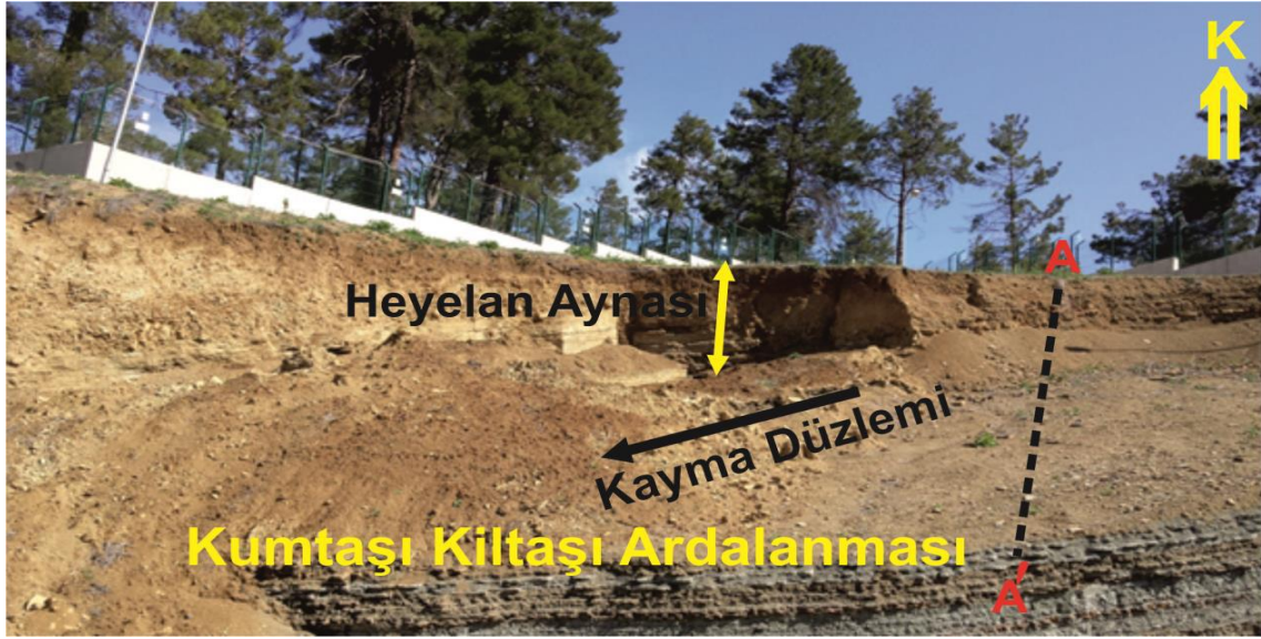
Şekil 3.13. A-A' kesitinin alındığı lokasyonda oluşan heyelanın görünümü
