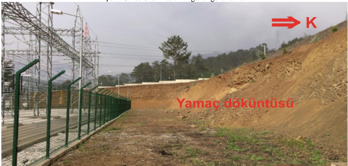
Şekil 3.19. C-C' kesitinde yağışın etkisi ile fiziksel ve kimyasal ayrışmaya bağlı olarak şev eğimi boyunca oluşan yamaç döküntüsü
