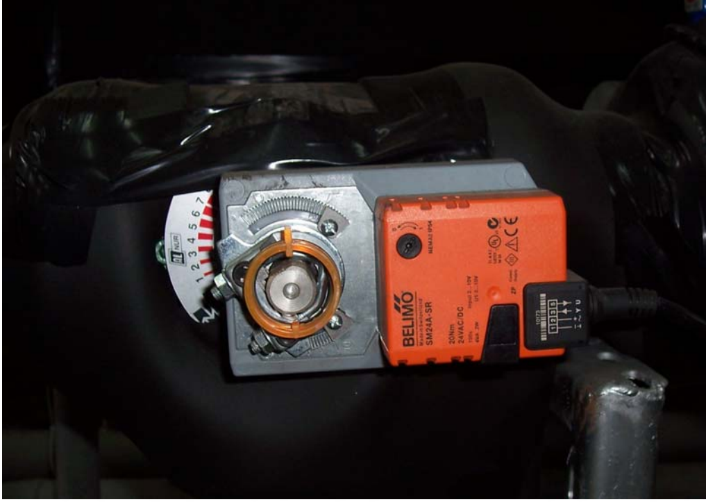
Şekil 3.10 Oransal kontrollü 3 yollu vana
