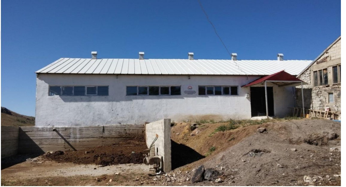
Şekil 4.5. Karabıyık köyünde bir işletmeye ait yeni yapılan bir ahırın dıştan görünümü
