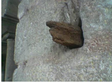
Şekil 2. 67 Eski Binalardaki koyulmuş ahşap hatıl Şekil 2. 68 Eski Binalardaki bozulan ahşap hatıl (sadece deliği kalan hatıl)
