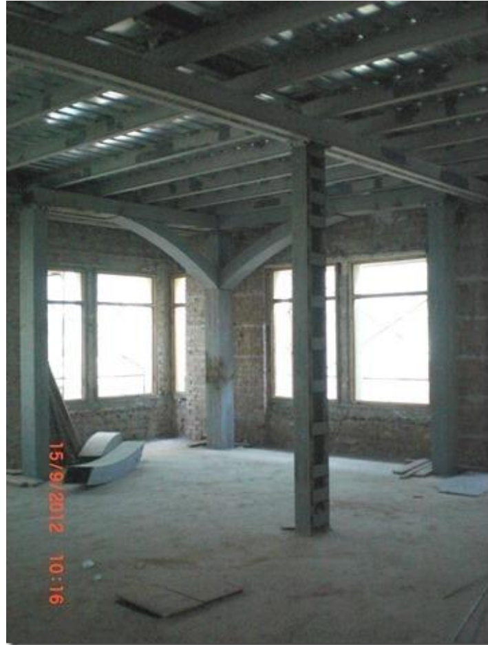
Şekil 5. 85 Bina güçlendirilmesi
