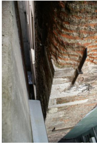
Şekil 2. 71 Hatıl ile güçlendirme
