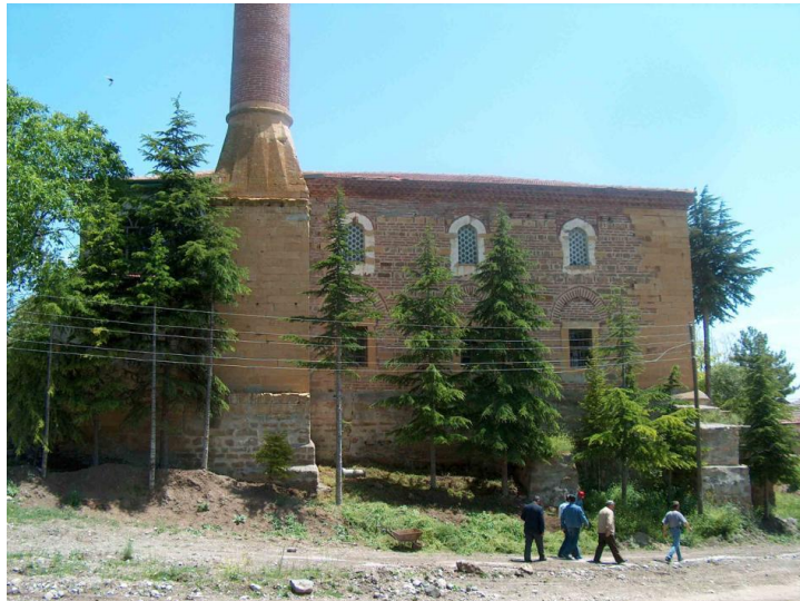
Şekil 2. 3 Taş tuğla karışımı taşıyıcı kargır duvar [4]
