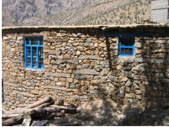
Şekil 2. 70 Eski binalardaki koyulmuş kısa ahşap hatıl
