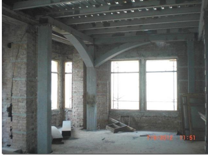
Şekil 6. 1 Kredî Han binanın güçlendirmesi
