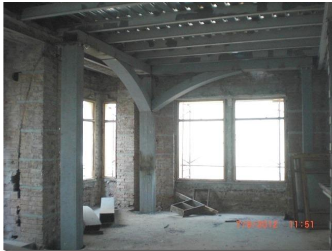
Şekil 2. 87 I çelik profil ile güçlendirme yöntemi (Bölüm 5'teki projesi)
