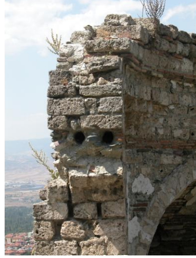
Şekil 2. 67 Eski Binalardaki koyulmuş ahşap hatıl Şekil 2. 68 Eski Binalardaki bozulan ahşap hatıl (sadece deliği kalan hatıl)
