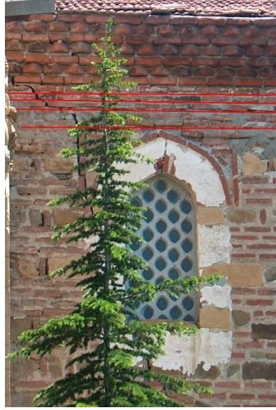
Şekil 2. 74 Eski binalardaki koyulmuş ahşap hatıl
