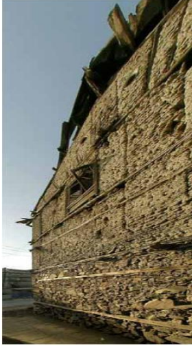
Şekil 2. 69 Eski binalardaki koyulmuş ahşap hatıl
