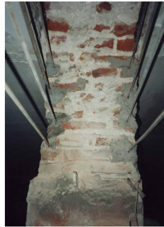
Şekil 2. 72 Bant ile güçlendirme
