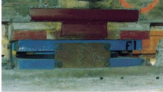
Şekil 2. 56 Kayar mesnet (P.Gülkan-ODTÜ)
