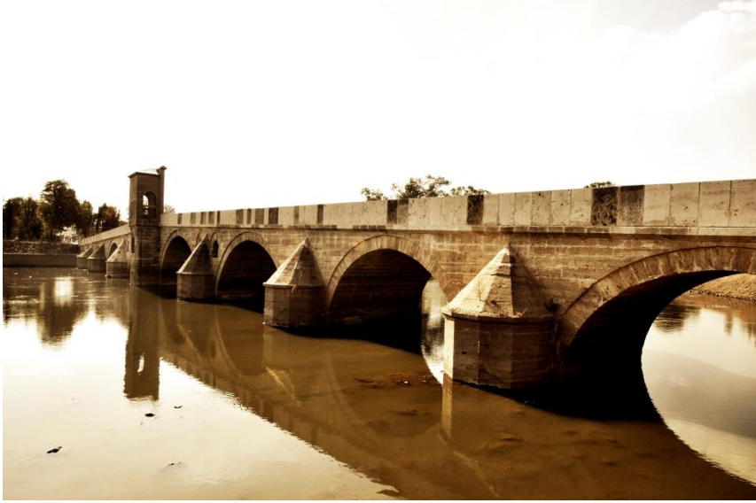
Şekil 7.43. Tunca Köprüsü (Savran, 2014)
