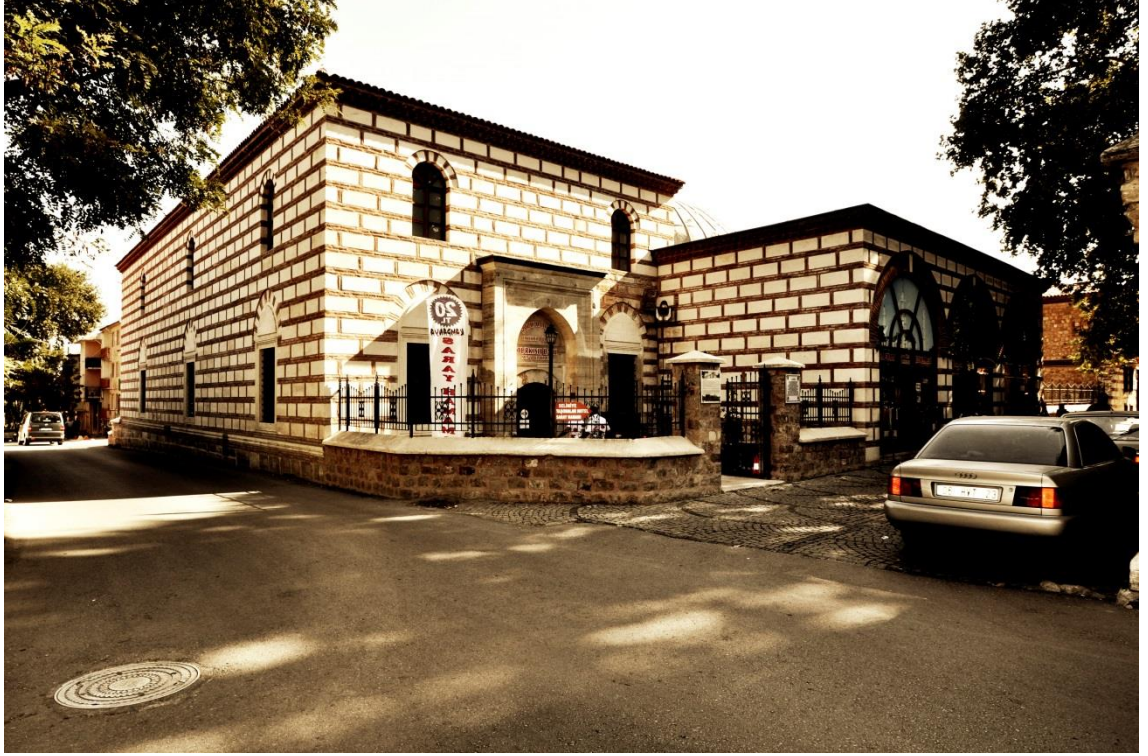
Şekil 7.15. Sultan Selim Sarayı Hamamı (Çakır, 2014)
