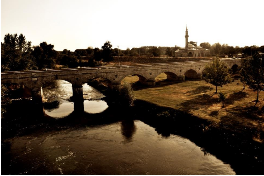
Şekil 7.69. Gazimihal Köprüsü (Savran, 2014)
