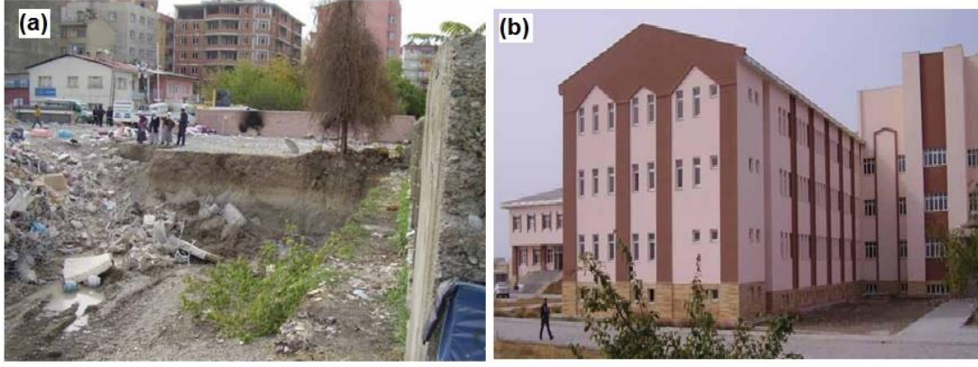
Şekil 1.19 : (a) Bahçivan Mahallesi’nde göçen 2 betonarme binanın arkasındaki dik kazı. (b) Van Yüzüncü Yıl Üniversitesi Tıp Fakültesi’ne ait bina.
