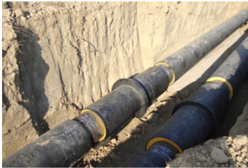
Şekil 3.12. Ön yalıtımlı borular ve zeminde uygulaması.
