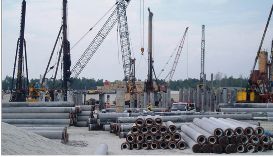
Şekil 2.6: Farklı uzunlukta çakmaya hazır haldeki kazıklar.
