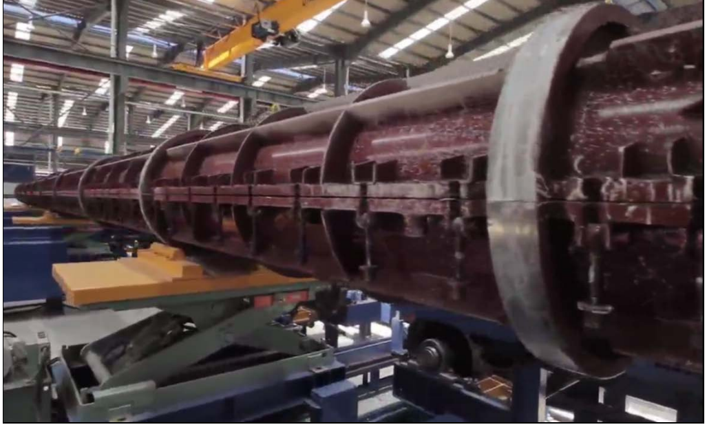
Şekil 3.14: Kapatılmış kazık kalıbının birinci aşaması.
