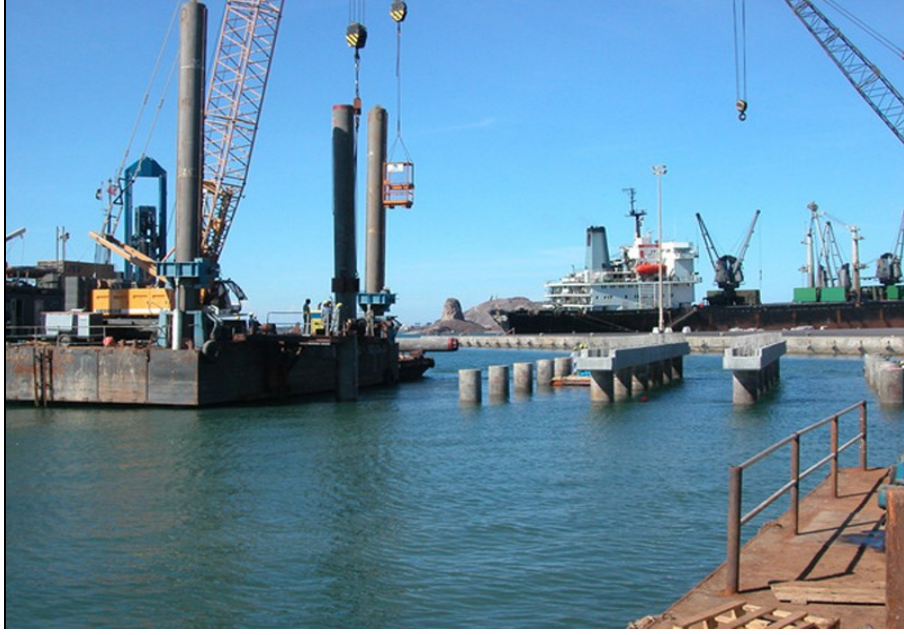
Şekil 2.8: Aden Konteyner Terminali.
