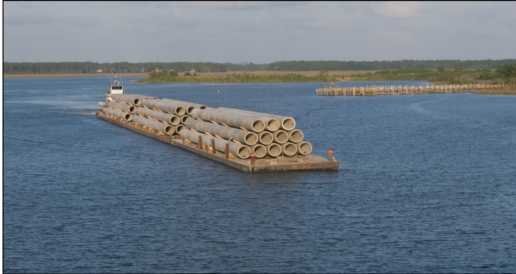
Şekil 2.5: Kazıkların yüzen platformlarla proje alanına taşınması.
