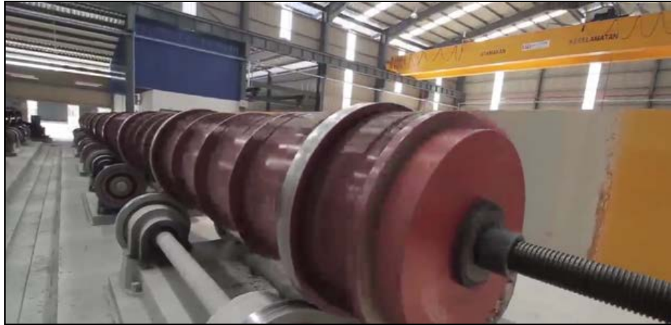
Şekil 3.21: Kazık betonun dökülmesinin hemen ardından gerçekleştirilen döndürme işleminin birinci aşaması.
