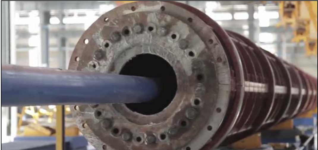
Şekil 3.19: Tiremi borusu ile beton dökülmesinin ikinci aşaması.
