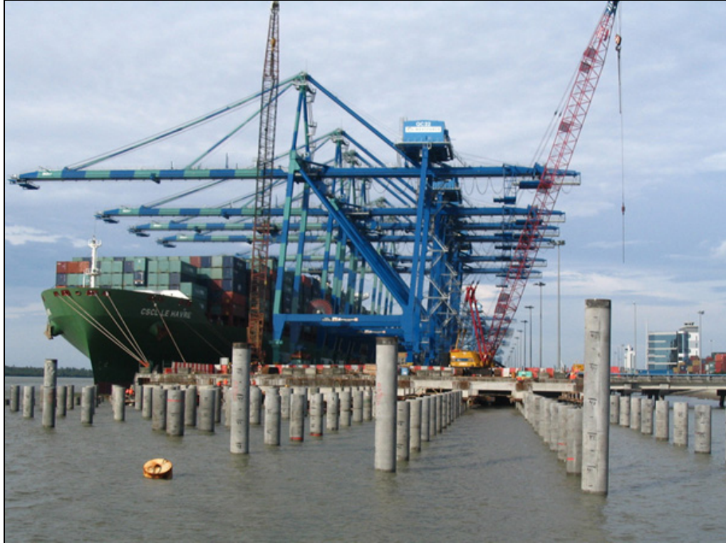
Şekil 2.1: Öngerilmeli prekast betonarme kazıklı konteyner terminali.
