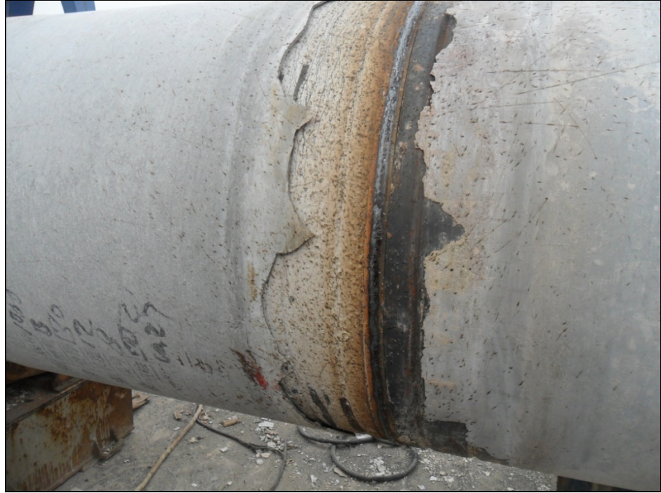
Şekil 3.35: Eklenmiş kazıkların kaynak ile sabitlenmesi.
