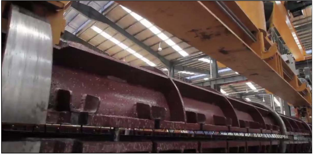
Şekil 3.13: Kazık üst kalıbının kapatılması.
