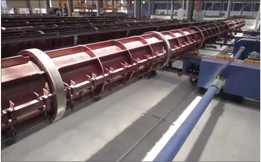
Şekil 3.15: Kapatılmış kazık kalıbının ikinci aşaması
