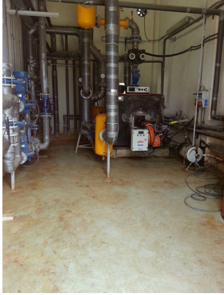
Şekil 4.8 Tokat AAT brülör-kazan
