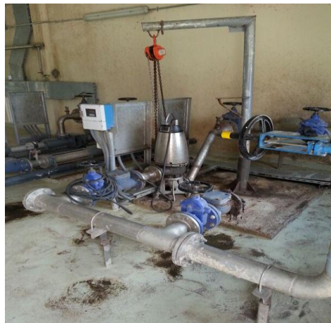
Şekil.4.3 Tokat AAT Besleme pompaları
