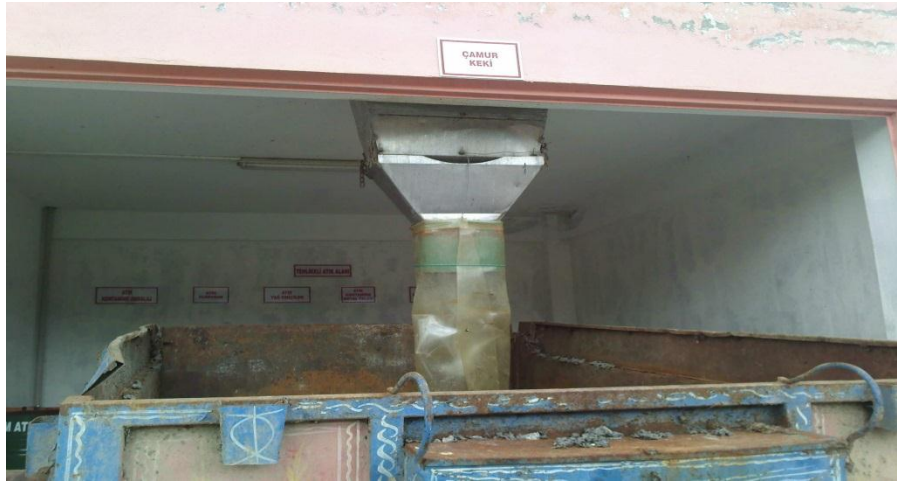
Şekil 4.13 Tokat AAT çamur kekinin kamyonlara yüklenmesi
