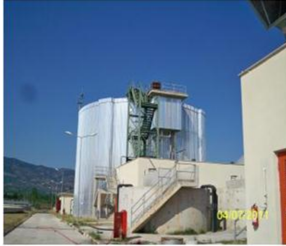
Şekil 4.2 Tokat AAT çamur homojenizasyon tankı ve anaerobik çamur çürütme tankı
