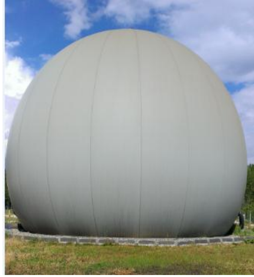
Şekil 4.6 Tokat AAT Biyogaz depolama tankı
