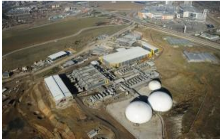
Şekil 2.4 Mamak çöp gazı santralinden genel görünüş
