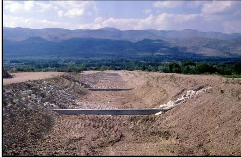
Şekil 2.11: İmalat sırasında brit uygulaması (Özbal, 2010).
