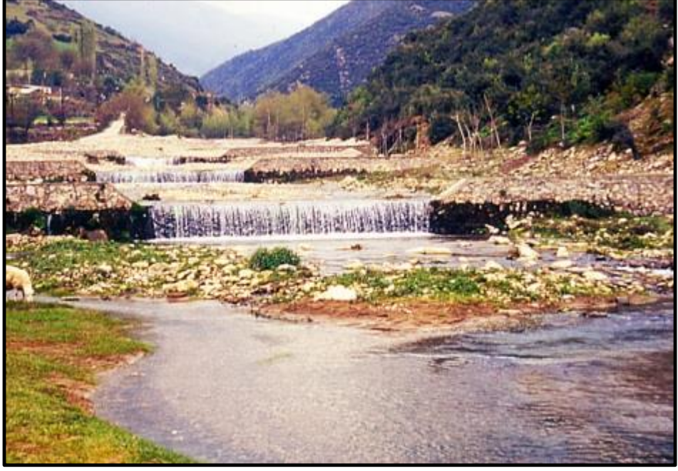
Şekil 2.10: Taban kuşağı örneği (Özbal, 2010).
