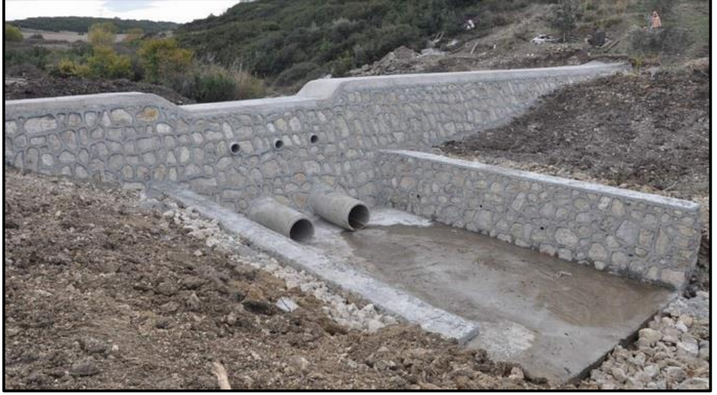
Şekil 2.8: İzmir Değirmendere Deresi üzerinde bulunan tersip bendi ( www.kha.com.tr ).
