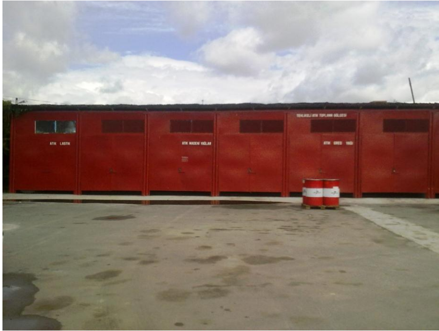
Şekil 6.11 Tehlikeli atık geçici depolama bölgesi
