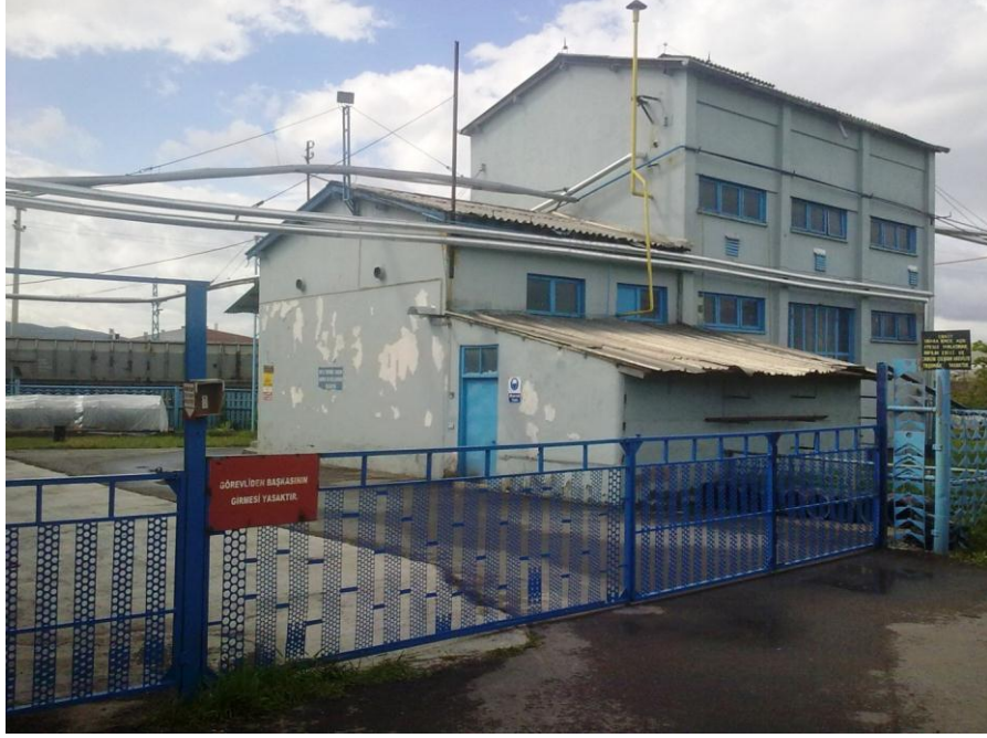
Şekil 4.9 Asetilen üretim tesisi.
