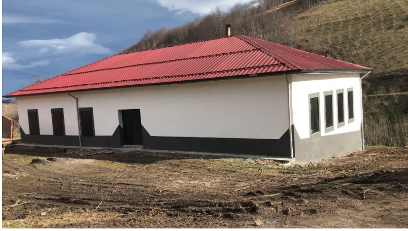
Görsel 3.7: Dernek katkısıyla restore edilen bir bina (URL-27).
