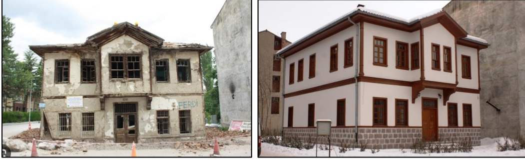
Şekil 65. Ali Şükrü Bey Konağı Restorasyon Öncesi ve Sonrası Hali
