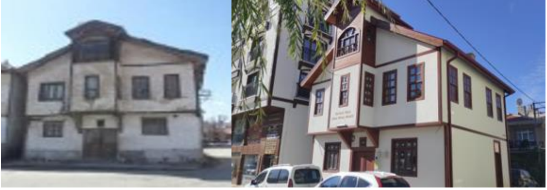
Şekil 77. Konyalı Terzi Musa Ünsal Konağı Restorasyon Öncesi ve Sonrası Hali
