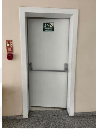
Resim 5. 18. Yangın çıkış kapısı
