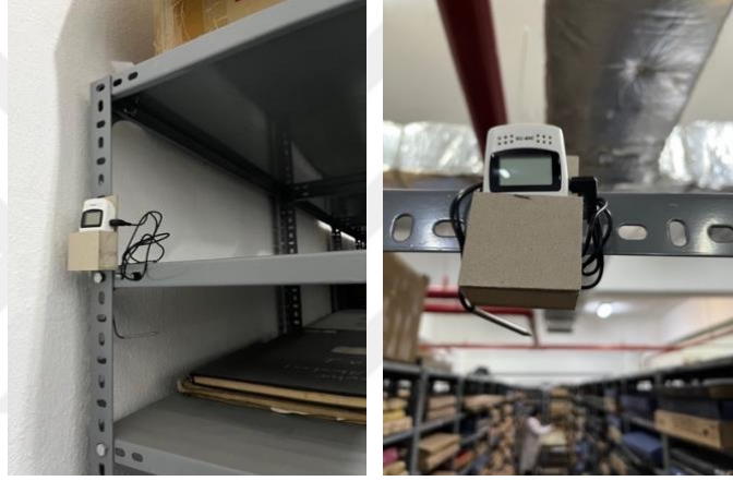
Resim 5. 2. Depo alanlarına yerleştirilen dataloggerlar
