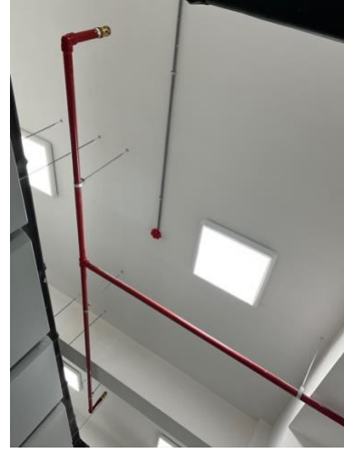
Resim 5. 34. Gazlı yangın söndürme sistemi
