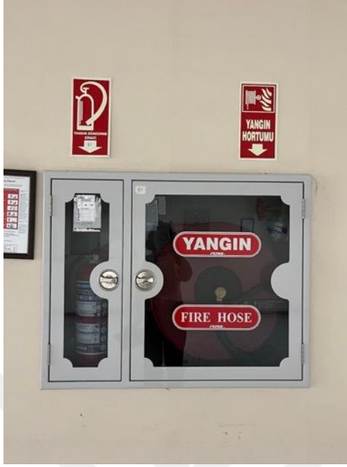
Resim 5. 21. Yangın dolabı
