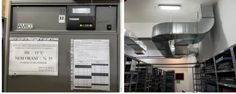
Resim 5. 1. İklimlendirme cihazı ve sistemi
