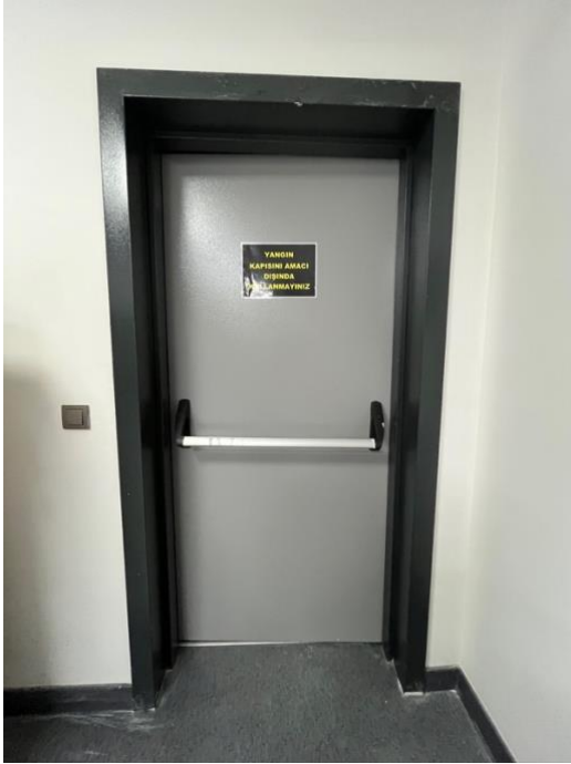
Resim 5. 35. Yangın çıkış kapısı
