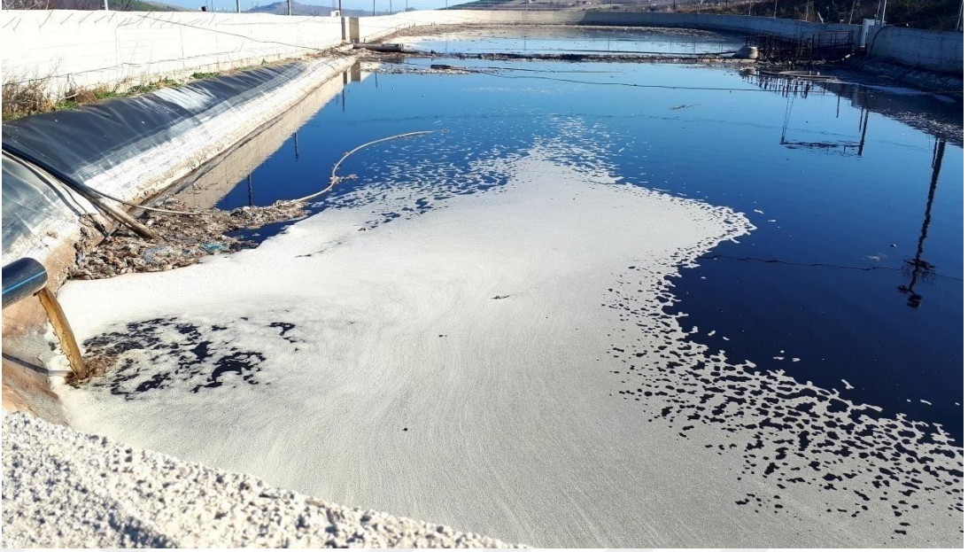
Şekil 8.2. Samsun Büyükşehir Belediyesi Katı Atık Düzenli Depolama Sahası sızıntı suyu toplama
