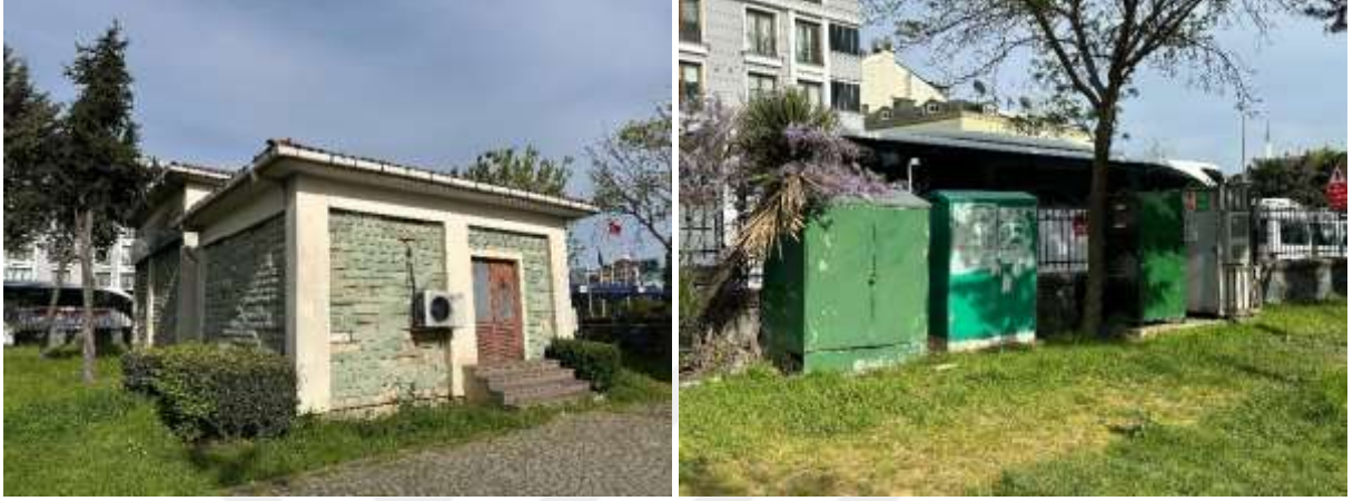
Şekil 5.17. Bayrampaşa şehir parkı afet sonrası enerji alanı
