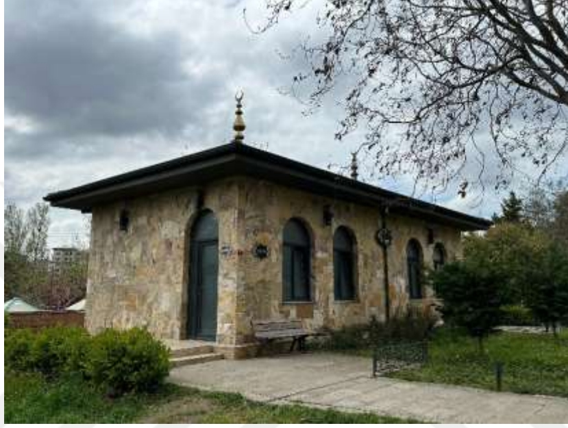
Şekil 5.19. Bayrampaşa şehir parkı afet sonrası mescit alanı
