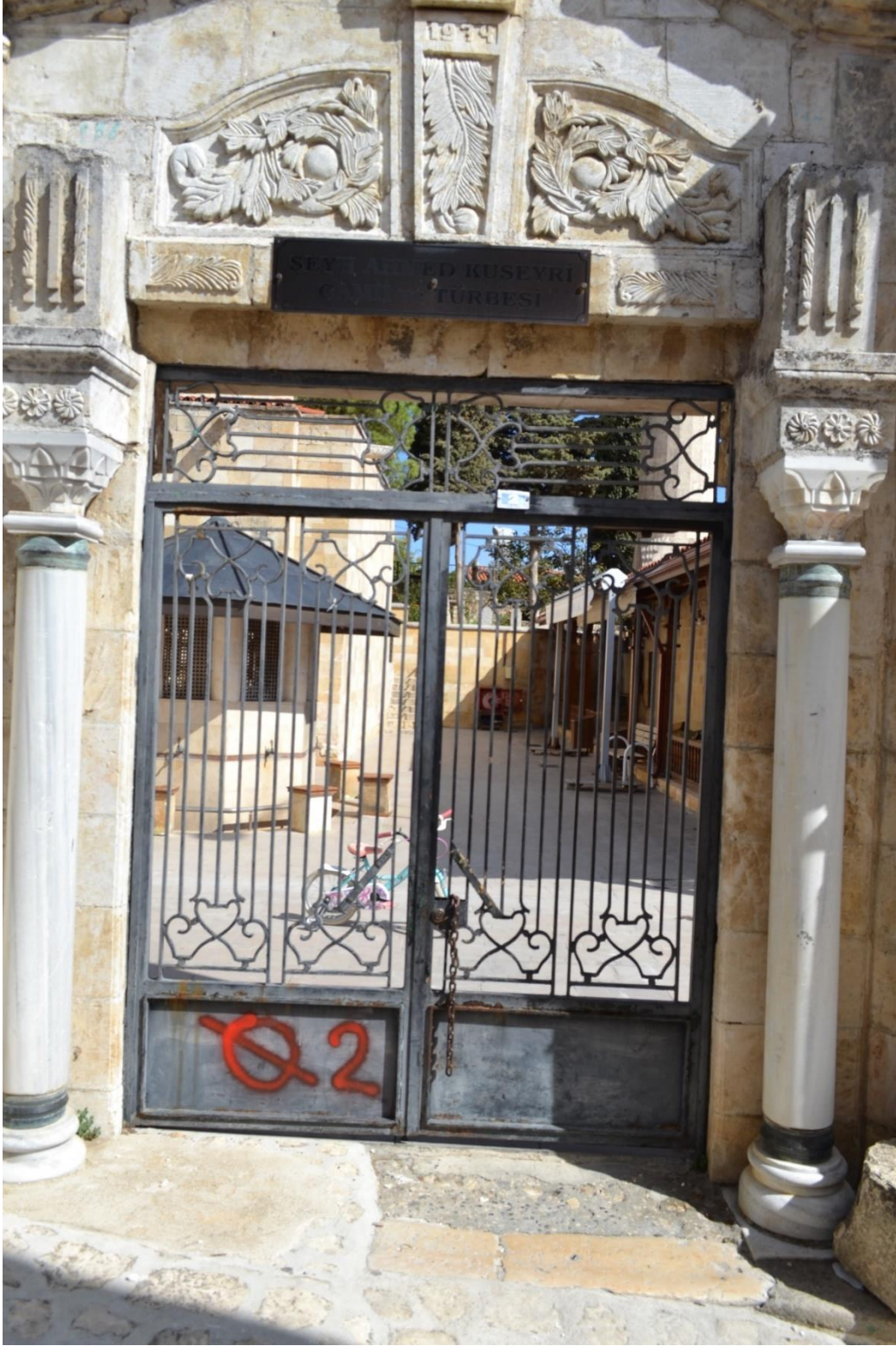
Resim 5. Şeyh Ahmet Kuseyri Türbesi ve Cami Giriş Kapısı
