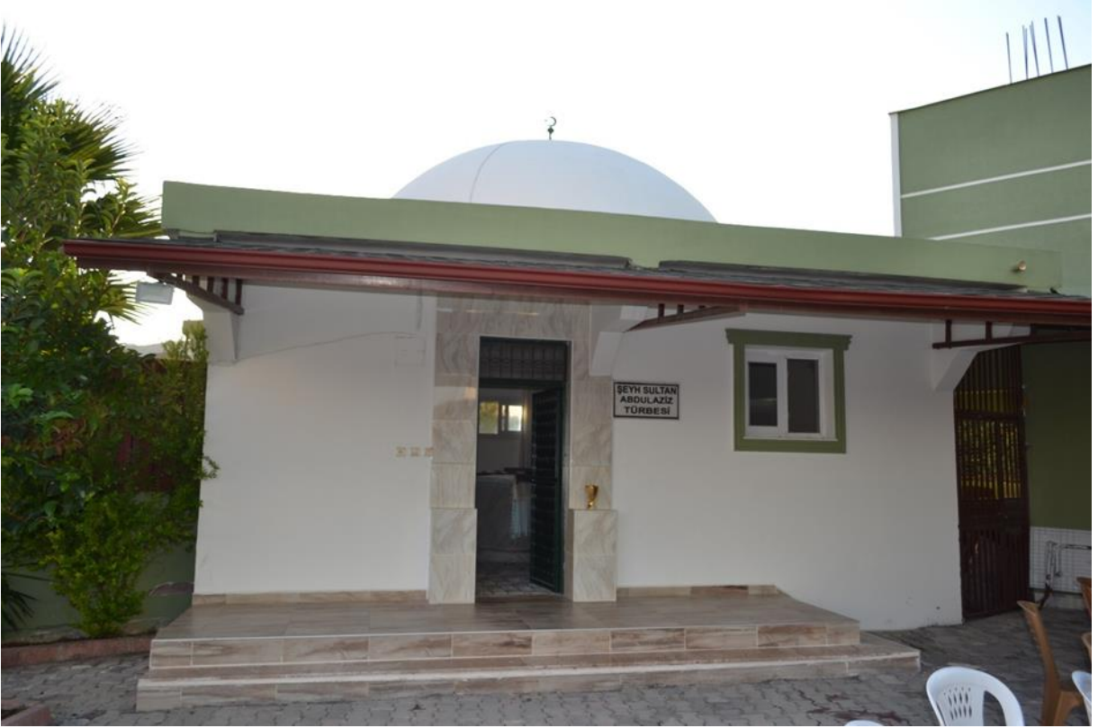
Resim 73. Şeyh Sultan Abdulaziz Türbesi Dış Görünüm
