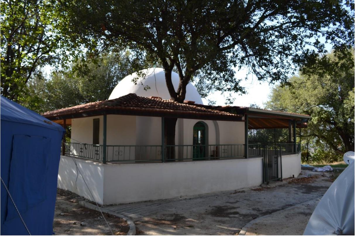
Resim 65. Şeyh Muhammet El Cedduğ Türbesi Dış Görünüm
