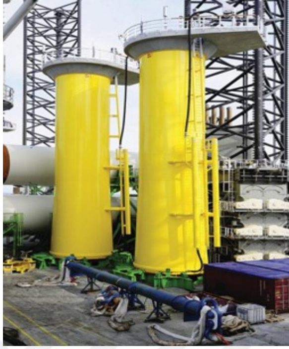
Şekil 1.3. Açık Deniz Rüzgar Çiftliği Geçiş Parçası (Kallehave vd., 2015)
