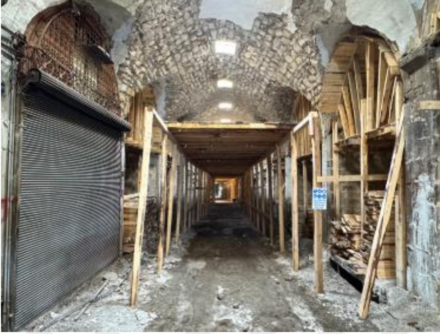
Şekil 28 Kahramanmaraş Kapalı Çarşı – Tonoz Örtülü Ana Aks Üzerinde Geçici Destekleme Sistemi
