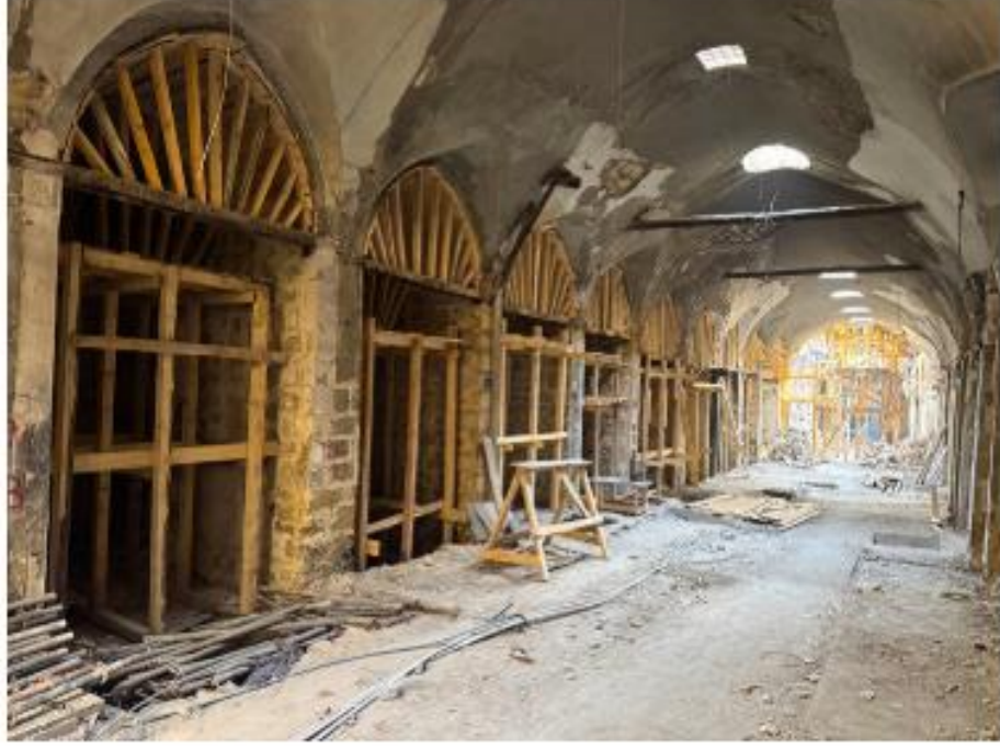
Şekil 27 Kahramanmaraş Kapalı Çarşı – Restorasyon Sürecinde Tonozlu Arasta Bölümü
