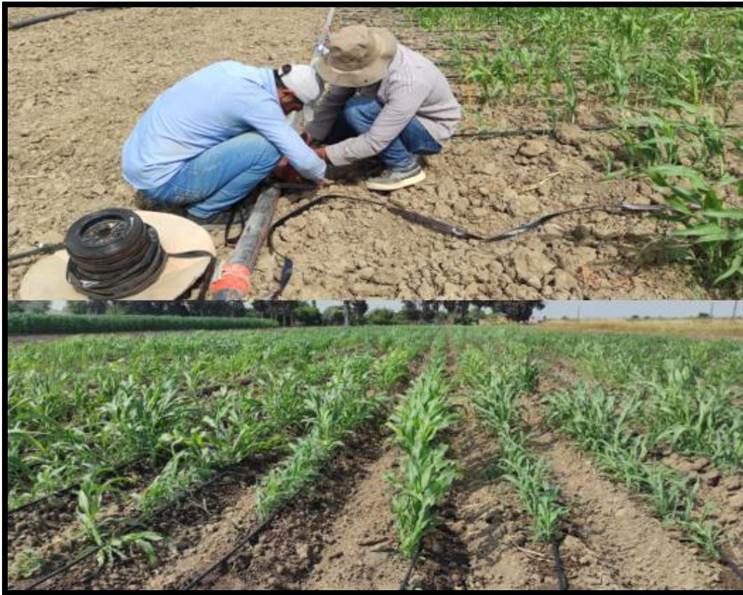
Resim 3.3. Tarla denemeleri damla sulama sistemi kurulumu
