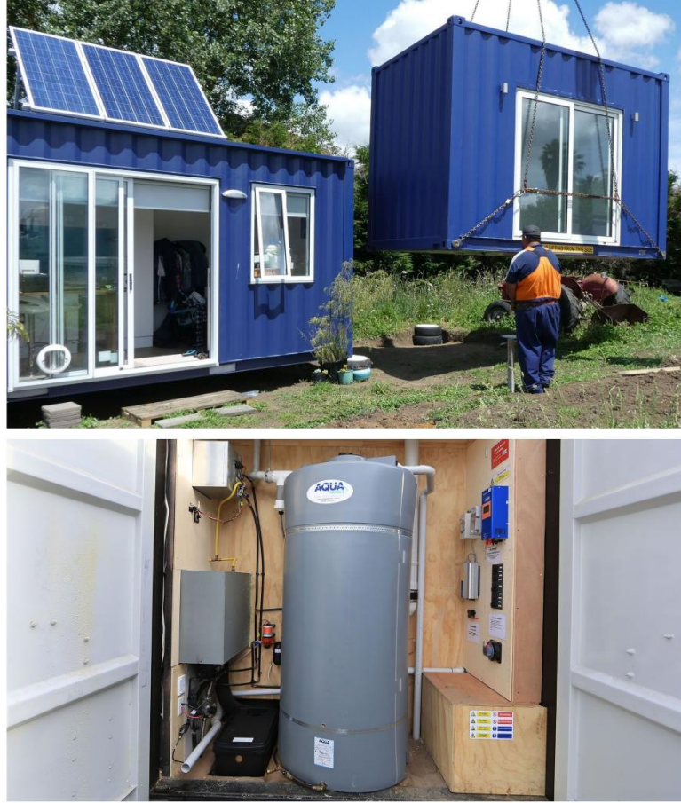
Şekil 40. Great Barrier ve Coromandal konteyner evi; güneş panelli ve yağmur suyu geri dönüşüm sistemine sahip sürdürülebilir konteyner ev (Kaynak:
