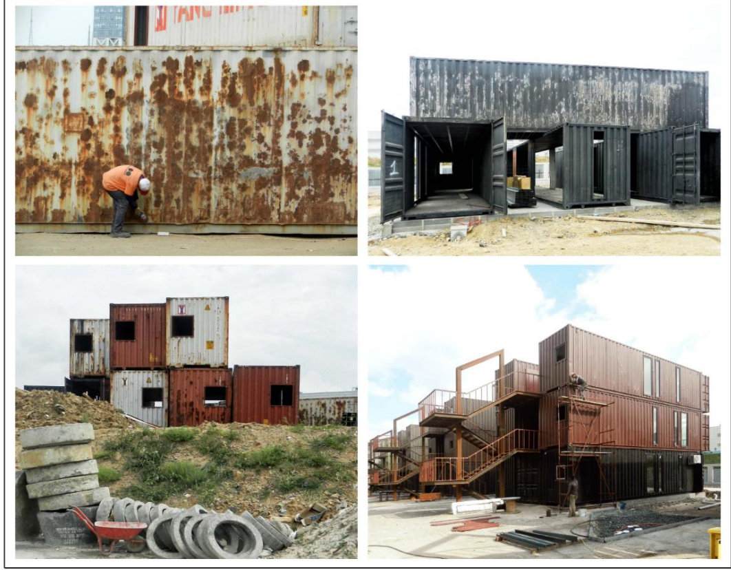
Şekil 52. Projenin, gerçek nakliye konteynerlerinin kullanıldığı inşaat sürecine ait görseller (Kaynak: https://www.arkiv.com.tr/proje/29-mayis-universitesi-elmalikent-erkek-ogrenci-yurdu/10970 – Erişim: 13.04.2025).
