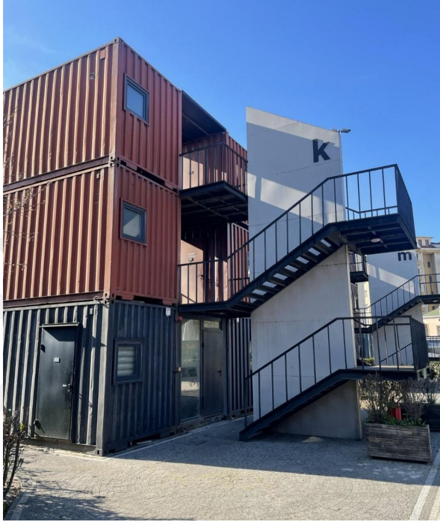
Şekil 59. Taşıyıcı çekirdek ve hafif merdiven strüktürü arasındaki kontrast (Paria Tanha, 2025).
