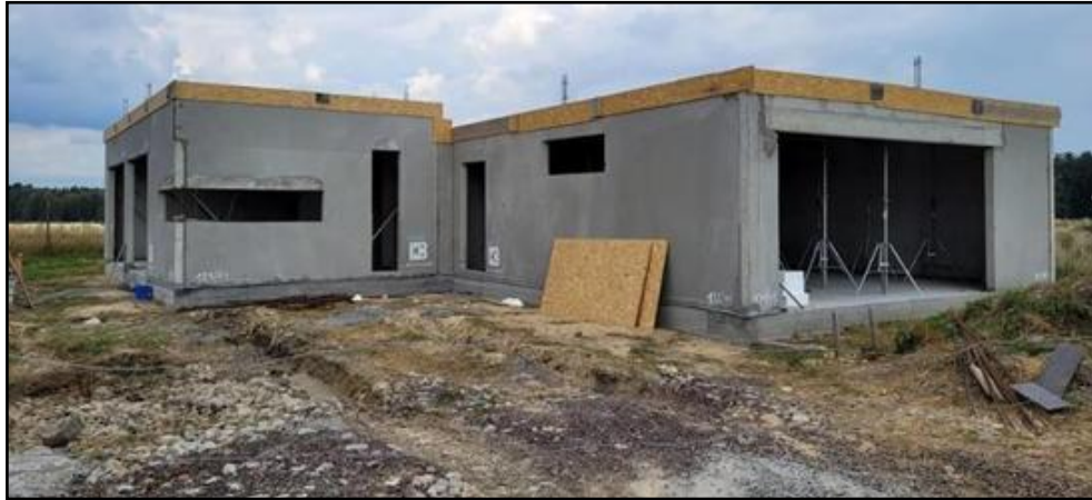
Şekil 12. Tek katlı ev, Rachowice - duvar montajı sırasında (Bradecki ,2022) tarafından çekilen fotoğraf.
