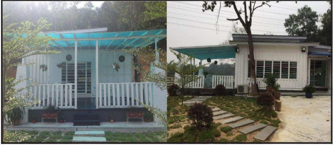
Şekil 14. Bukit Unggul, Jengkil, Selangor'daki Konteyner Tatil Evi (Foo, 2015).
