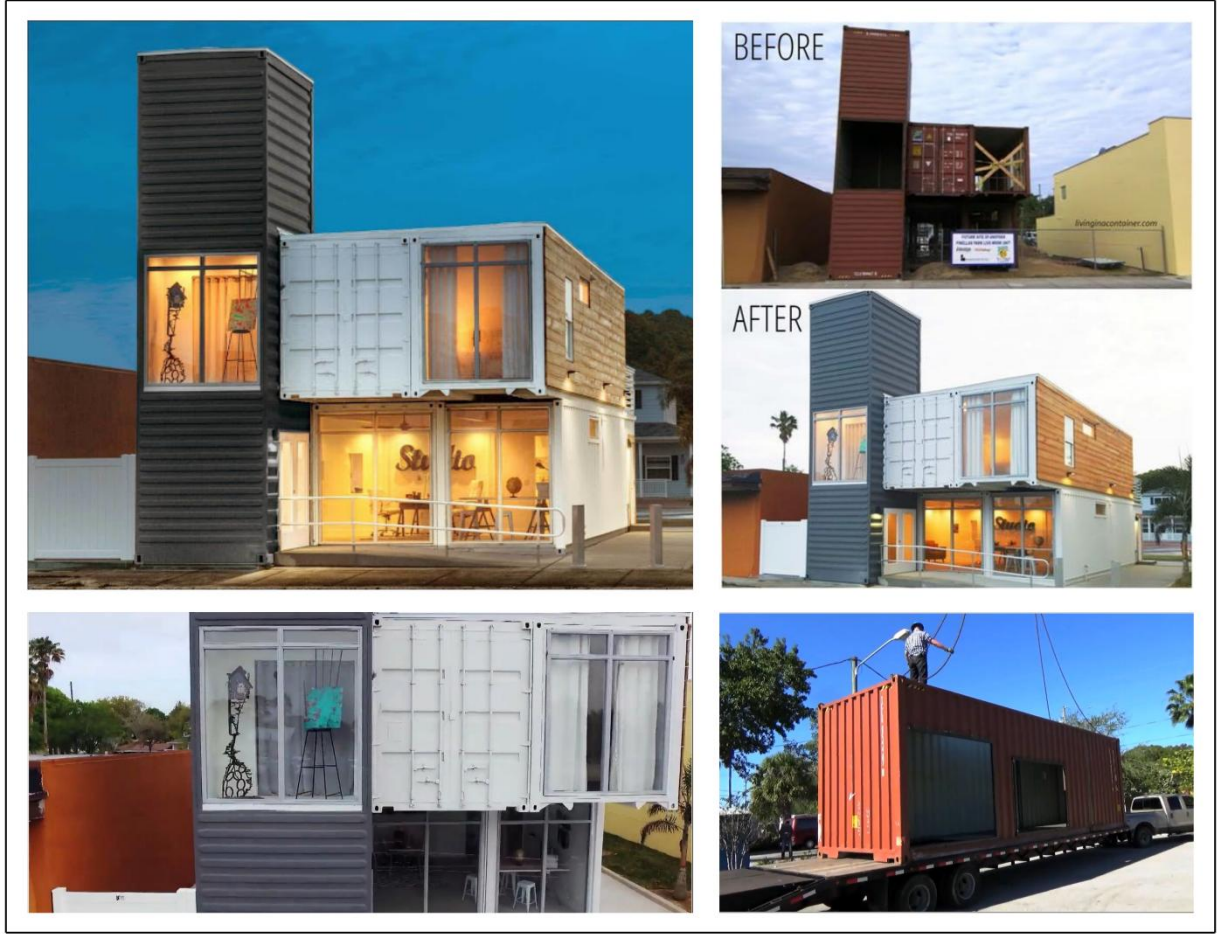
Şekil 38. Florida'daki Live/Work 2070 projesinden konteynerlerin dönüşüm süreci ve tamamlanmış yapıya ait görünüm (Mojica, 2023), (Kaynak:
