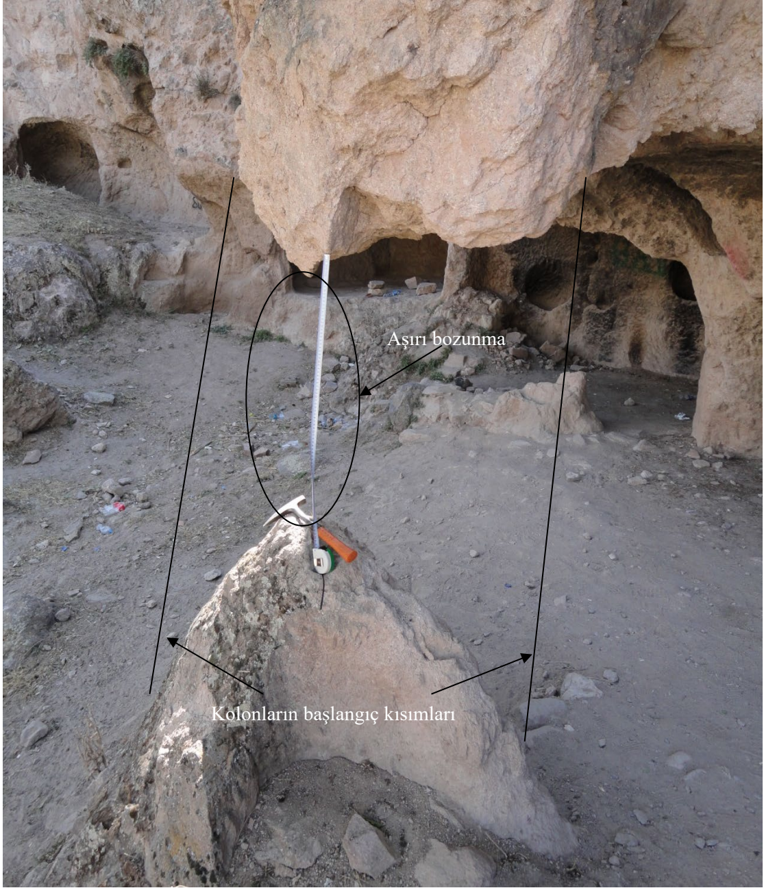
Şekil 5.10. Selçuklu ilçesine bağlı Sille Mahallesi'nde bulunan mağaraların giriş bölümlerinde gözlemlenen aşırı bozunma örneği.
