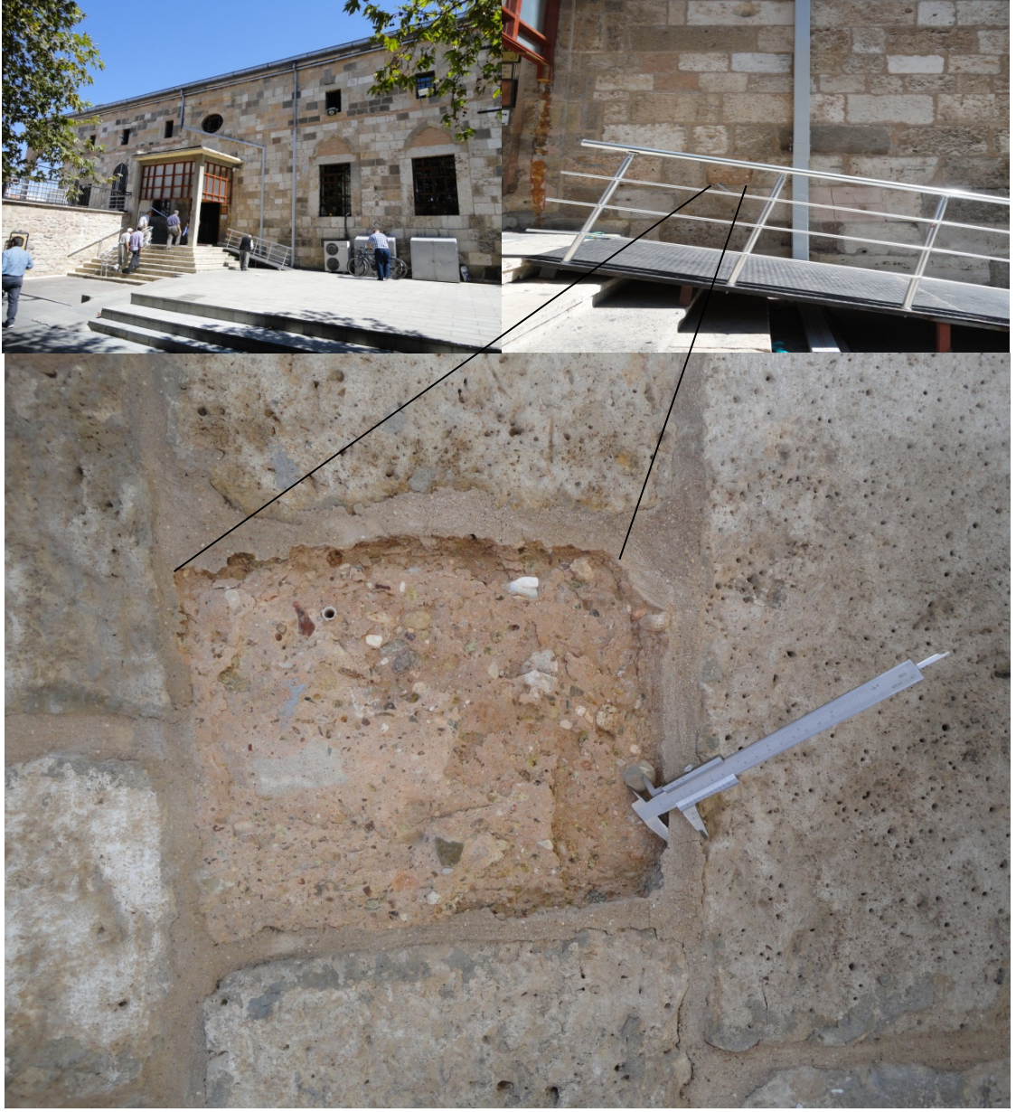
Şekil 5.5. Meram ilçesine bağlı Kapı Camii'nin kaplamasında kullanılan tüfte aşınma sonucu meydana gelen bozunma örneği.
