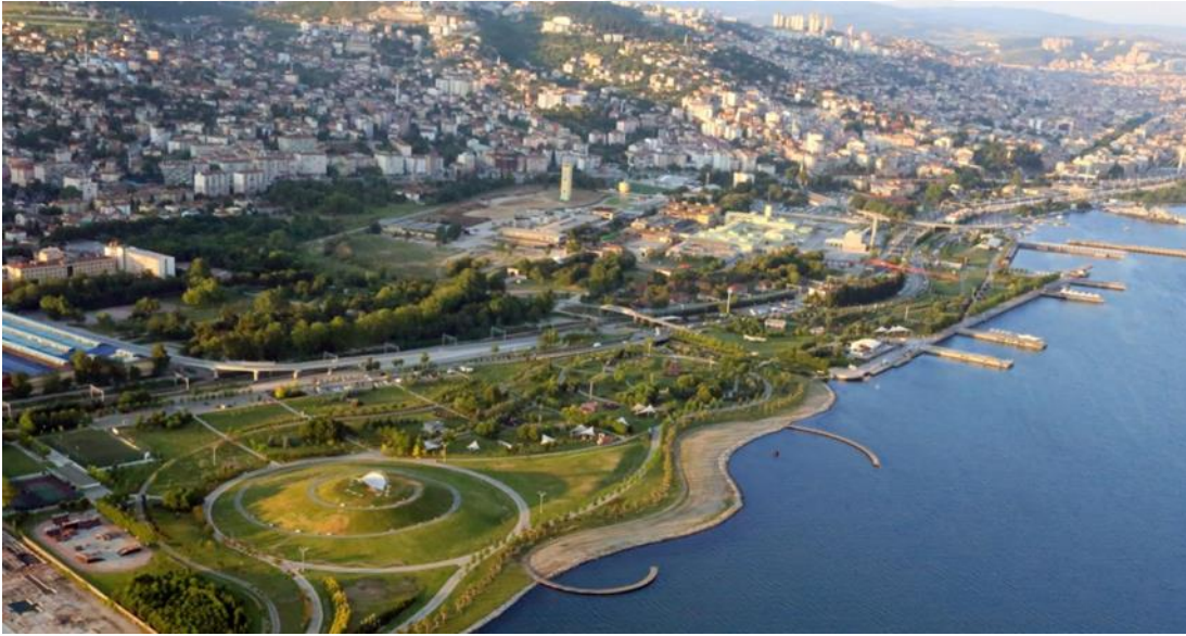
Şekil 5.36 SEKAPARK alanına ait hava fotoğrafı (URL-27)
