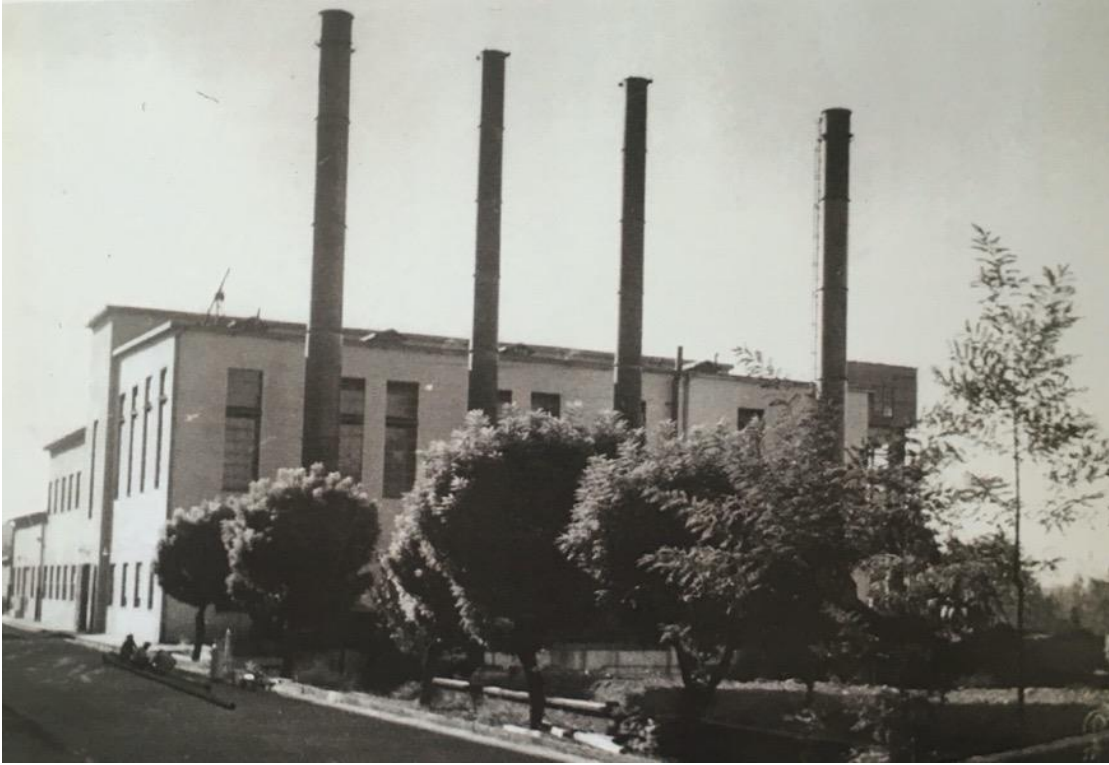
Şekil 5.10 Fabrikanın enerji ihtiyacını karşılamak için yapılan Enerji Santrali (Kaynak: Bursa Büyükşehir Belediye Arşivi)
