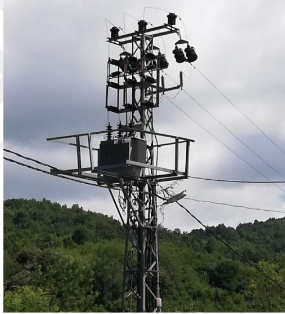
Őekil 1.7 Direk tipi 400 kVA altı trafo
