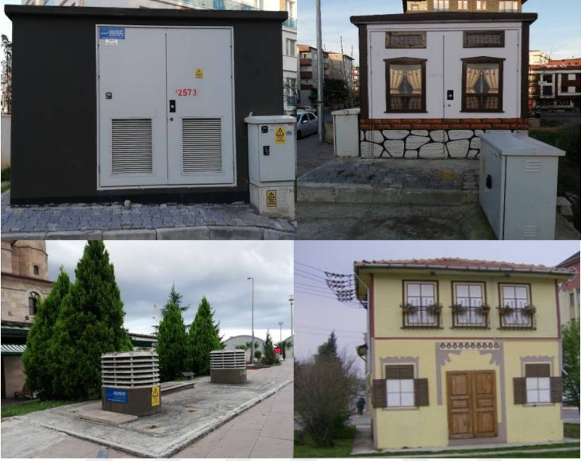
Şekil 1.5 Trafo kabin tipleri
