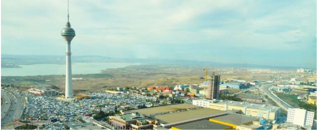
Şekil 3.31 Büyükçekmece televizyon kulesi [148]
