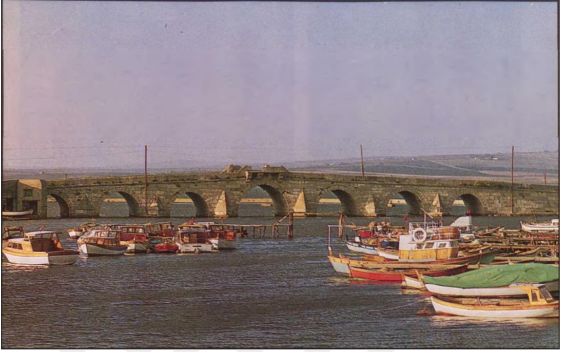
Şekil 3.27 Büyükçekmece’de ki Mimar Sinan Köprüsü [97]
