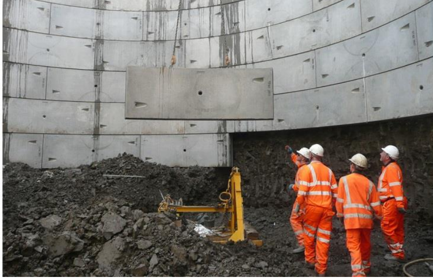
Şekil 2.3 Segmental kaplama uygulaması (FP McCann LTD.)
