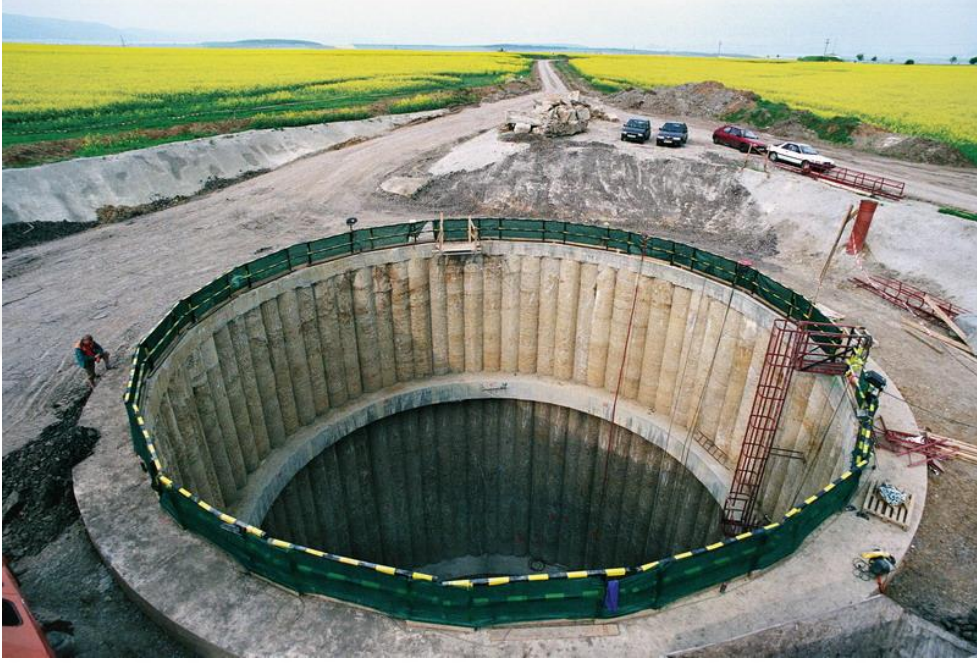
Şekil 2.2 akışan kazık uygulaması (Zakladani Staveb Co., 2004-2006)
