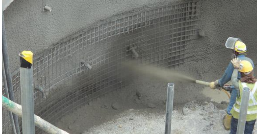
Şekil 2.5 Püskürtme beton şaft (Multibase Holdings PTE LTD, 2013)
