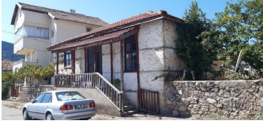
Şekil 3.60 Tescilli yapının günümüz durumu (2019)
