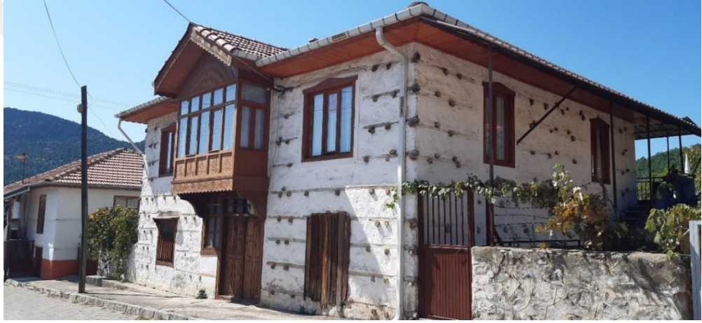
Şekil 3.58 Tescilli yapının günümüz durumu (2019)
