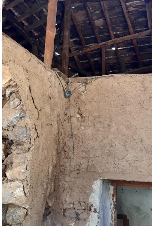
Şekil 3.17 Cevizli Mahallesi iç sıva örneği (2019)
