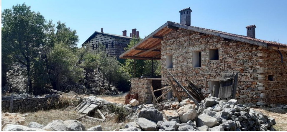
Şekil 3.91 Yapımı devam eden Düğmeli Ev örneği (2019)
