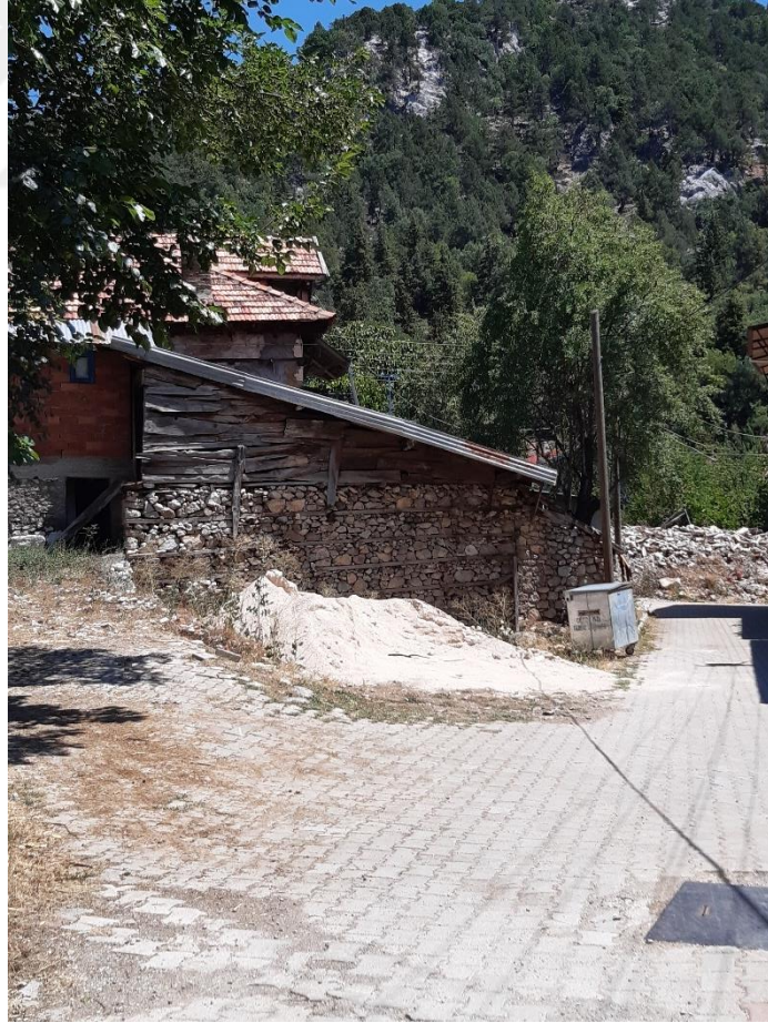
Şekil 3.85 Kullanılmayan yapının yıkılarak yok edilmiş son hali (2020)
