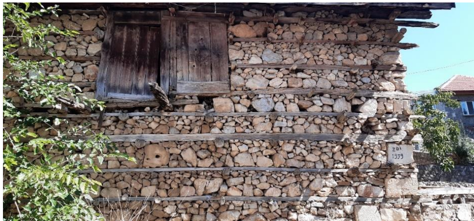
Şekil 3.3 Taş duvar örneği (2019)
