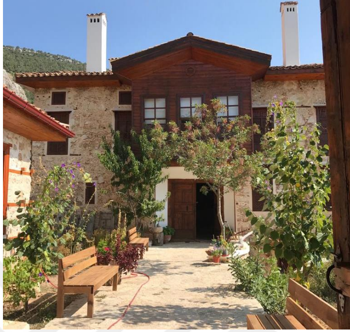
Şekil 3.23 Akseki’de korumaya alınan yapı ve bahçesi (2019)
