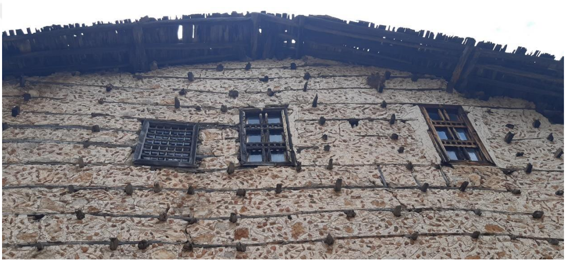
Şekil 3.1 Cephede düğmelerin(hatılların) görüldüğü Düğmeli Ev örneği (2020)
