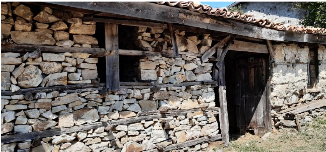
Şekil 3.10 Kuru duvar tekniği (2019)
