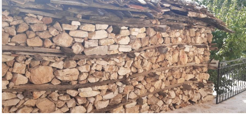
Şekil 3.24 Müdahale edilmemiş ve terkedilmiş yapının durumu (2019)
