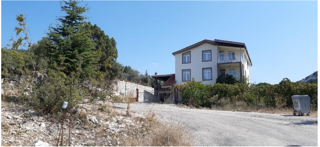
Şekil 3.48 Belenalan Mahallesi'nde yeni yapılan betonarme yapı (2019)
