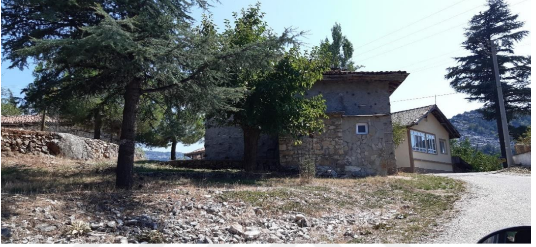
Şekil 3.47 Belenalan Mahallesi'nde yeni yapılan betonarme yapı (2019)
