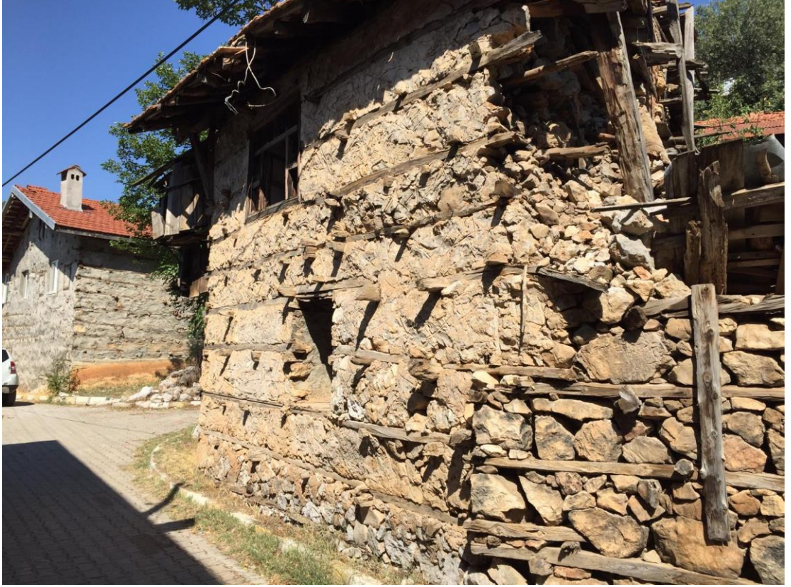
Şekil 3.15 Değirmenlik Mahallesi dış duvar yüzeyi örneği (2019)
