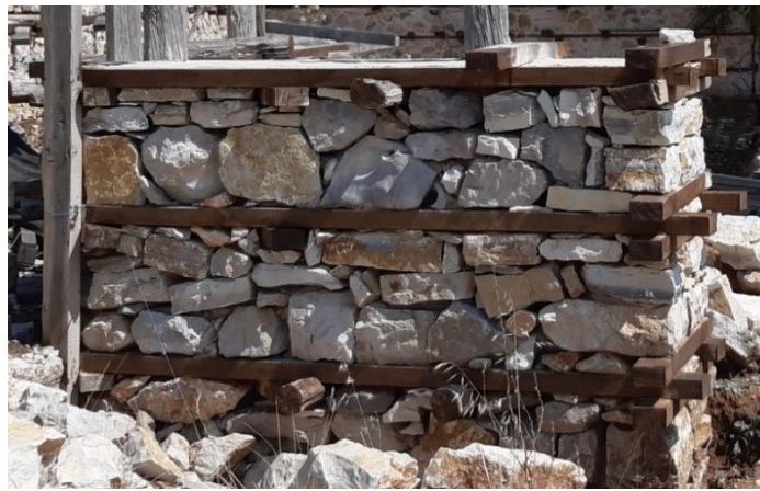
Şekil 3.14 Uygulanan hatıl birleşim detayı (2019)
