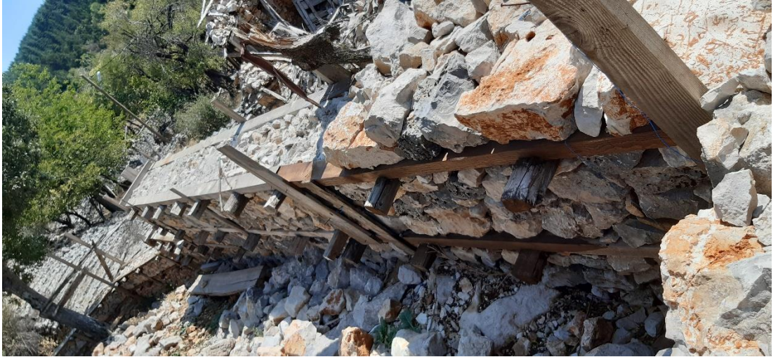
Şekil 3.5 Kuru duvar örme tekniği uygulaması (2019)
