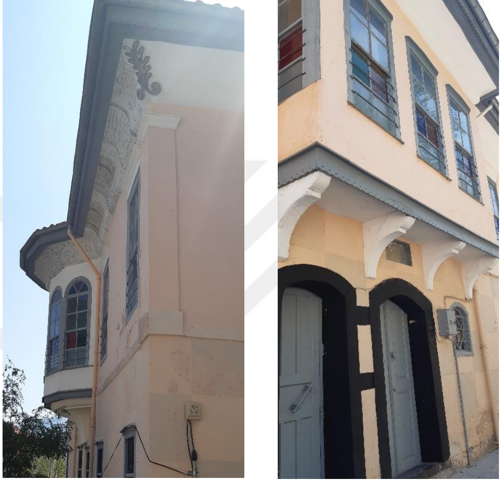
Şekil 3.33 Tescilli yapının günümüz durumu (2019)
