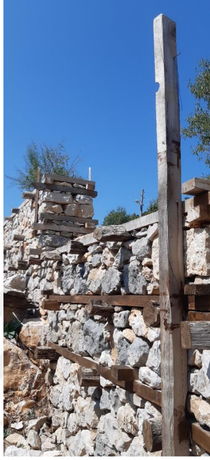
Şekil 3.95 Özgün duvar yapım tekniği örneği (2019)
