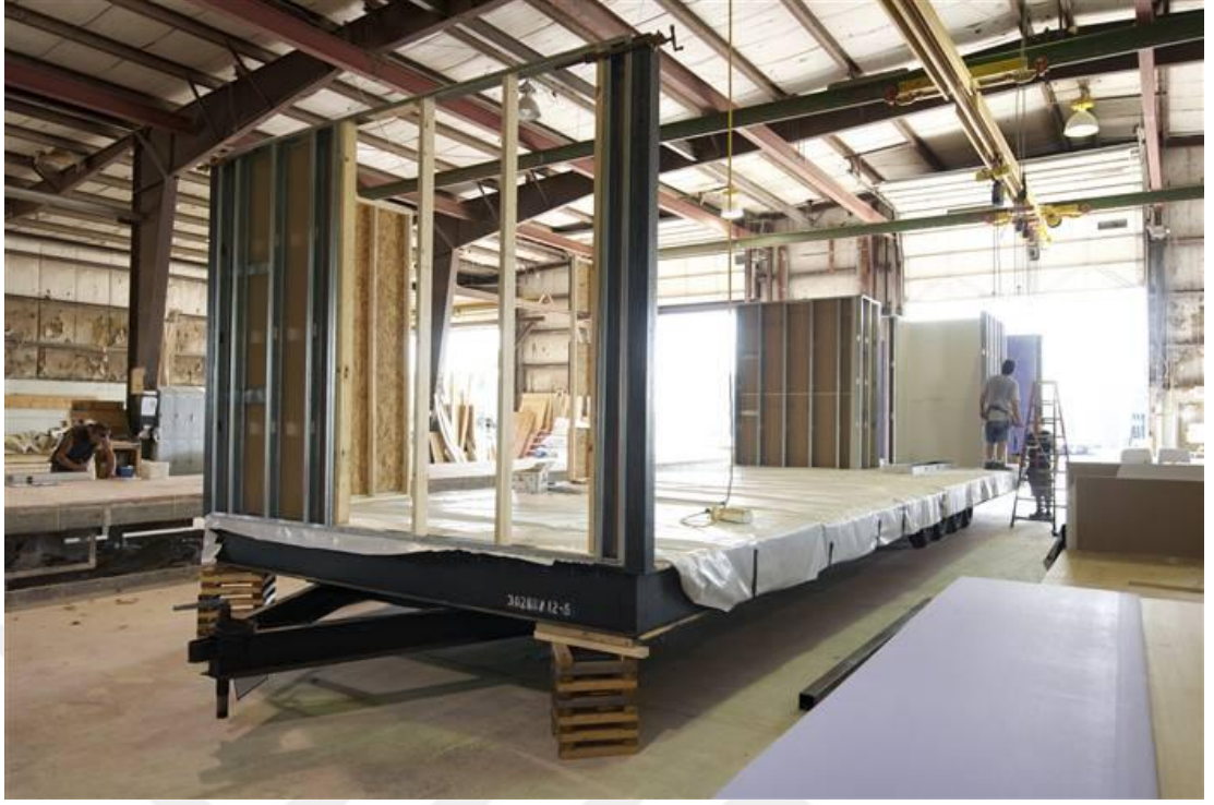
Şekil 4.15 Fabrika ortamında modüllerin oluşturulması (Modular Genius, 2018)
