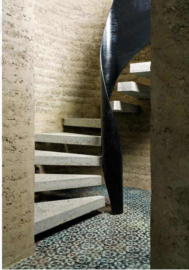
Şekil 4.4 Sıkıştırılmış toprak duvara bağlanan merdiven (MiesArch, 2018)
