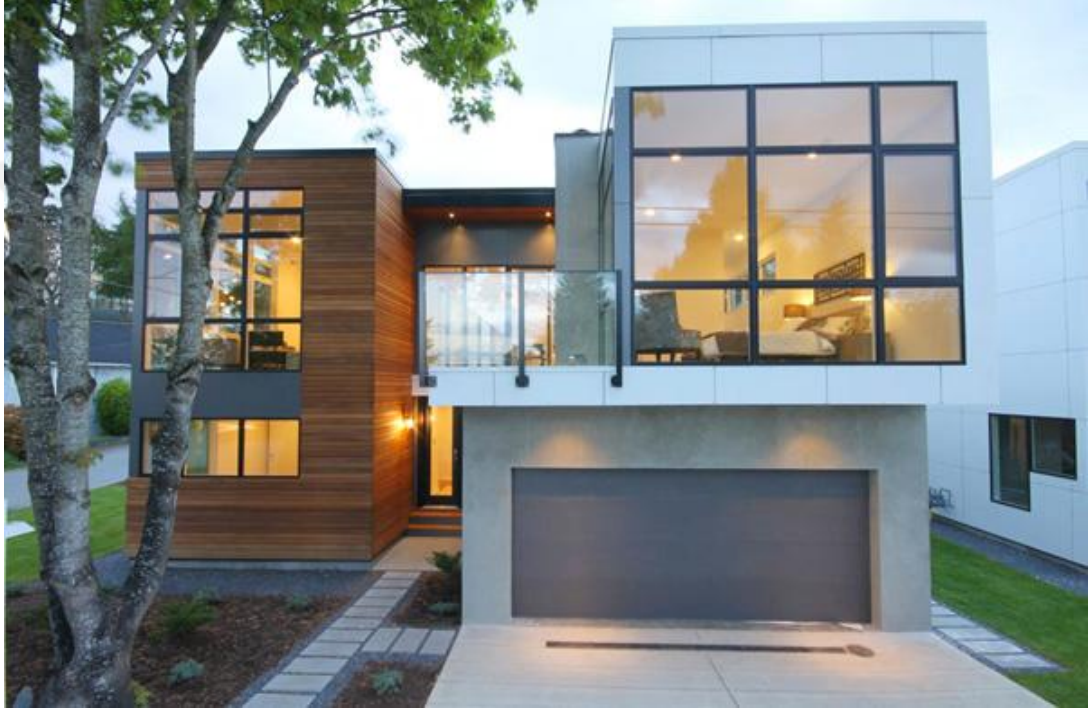
Şekil 4.17 Beachaus I Konut Yapısı, White Rock, İngiltere (Mihai, 2012)
