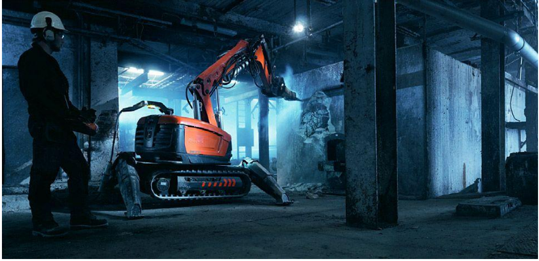
Şekil 3.3 Tehlikeli olan yıkım işlerinin uzaktan kumandalı robot ile yapılması (Uncrate, 2018)
