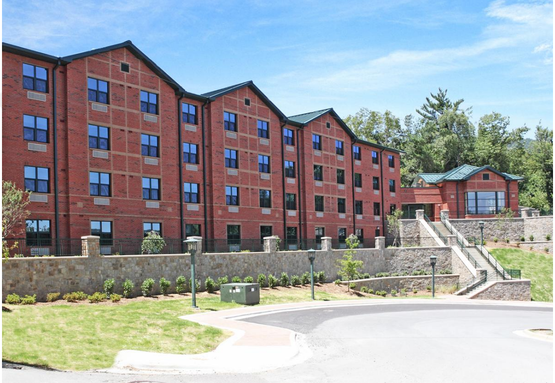
Şekil 4.31 Mountaineer Yurt Binası, Boone, Amerika Birleşik Devletleri (AppState, 2018)
