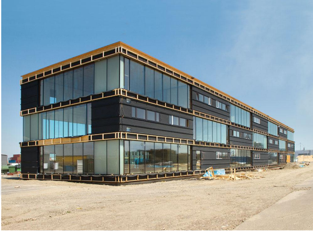
Şekil 4.8 Modüllerin şantiye ortamında birleştirilmesi (Schittich ve Schoof, 2011)
