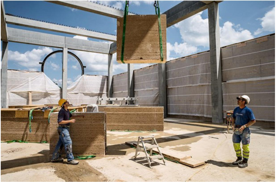
Şekil 4.2 Prefabrik sıkıştırılmış toprak duvar modülleri (LehmTonErde, 2012)
