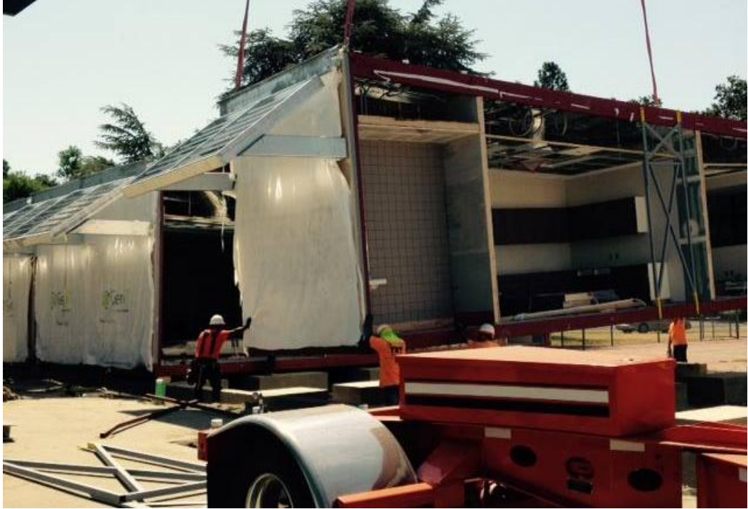
Şekil 4.30 Modüllerin şantiye ortamına getirilmesi ve montajı (Gen7 Schools, 2013)
