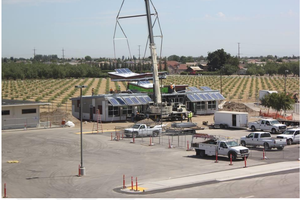
Şekil 4.29 Foto voltaik panellere sahip çatının inşaat sırasında vinç yardımı ile yerleştirilmesi (Gen7 Schools., 2013)
