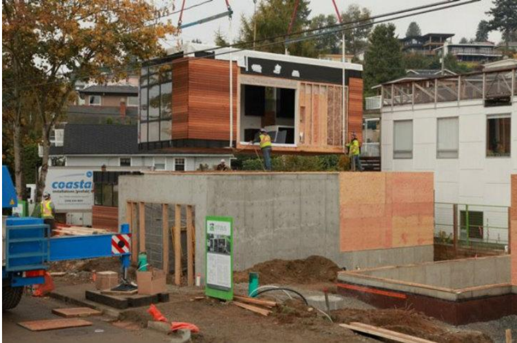
Şekil 4.19 Beachaus I binasında kullanılan modülün vinç yardımı ile yerine yerleştirilmesi (Meinhold, 2012)
