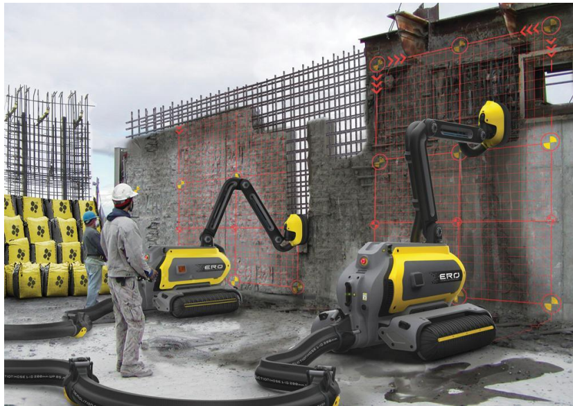
Şekil 3.2. Robot yardımı ile betonarme perde duvar yapımı (Francis, 2016)
