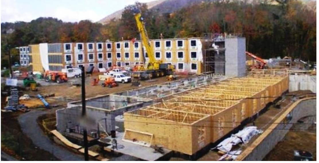
Şekil 4.33 Mountaineer Hall binasında kullanılan hafif ahşap çerçeve modüllerin şantiye ortamına taşınması ve montajı (Building Desing + Construction, 2012)
