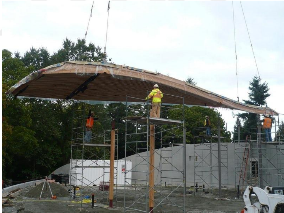
Şekil 4.36 Prefabrik çatı panellerinin vinç yardımıyla yerleştirilmesi (Structure Craft, 2018)
