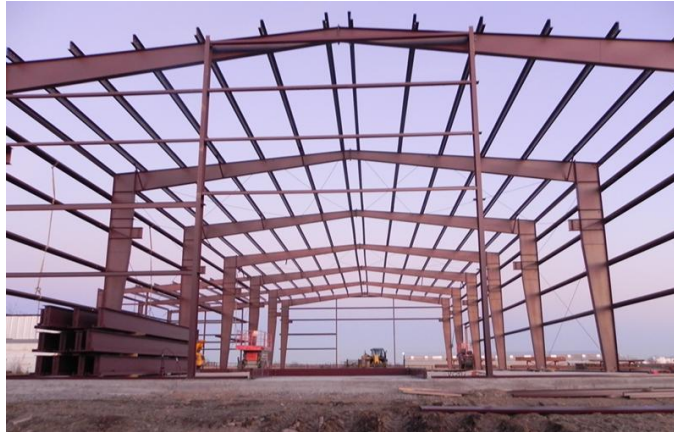
Şekil 3.4 Bir endüstri yapısında prefabrik çelik iskelet sistem uygulaması (Lucas Metal Works, 2018)
