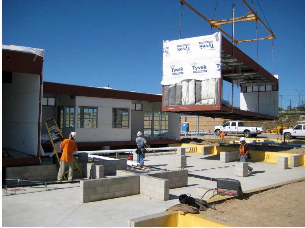
Şekil 4.27 High Tech Lisesi yapımında kullanılan modüllerin vinç yardımıyla yerleştirilmesi (AIA, 2011)
