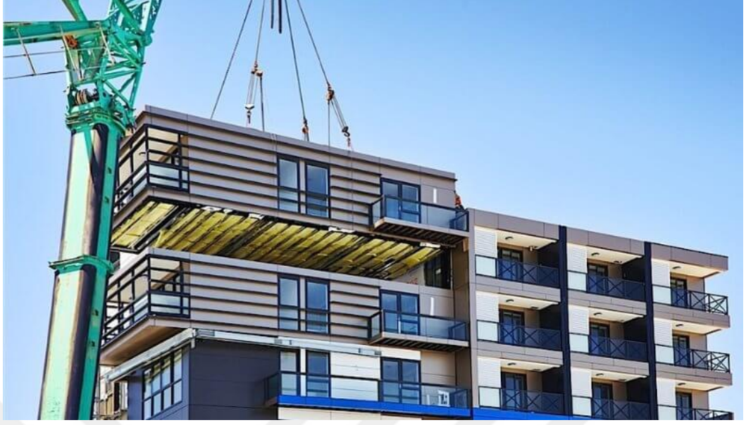
Şekil 3.6 Bir modülün vinç yardımıyla yerine yerleştirilmesi (Kelly, 2018 )
