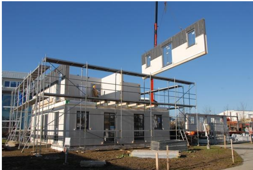
Şekil 3.5 Prefabrik panellerin inşaat alanında vinç ile taşınması (Casa-prefabricata, 2018)
