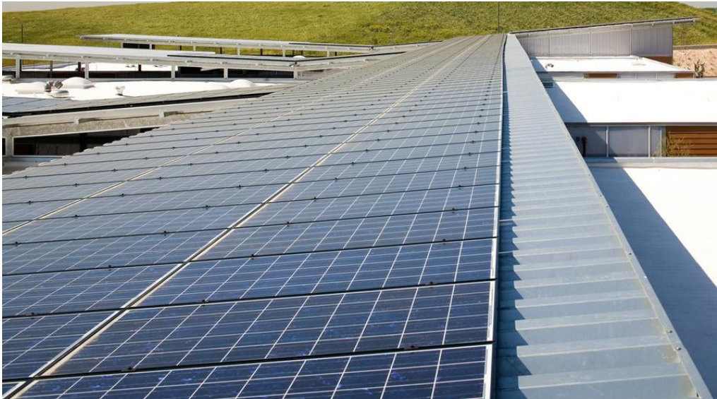
Şekil 4.26 Bina çatısında bulunan fotovoltaik paneller (ArchDaily, 2018)
