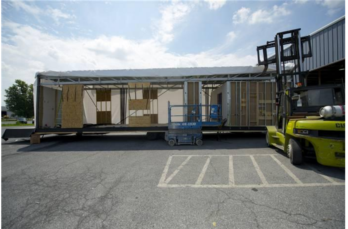
Şekil 4.16 Fabrika ortamında oluşturulan yüksek oranda bitmiş olan modülün şantiye ortamına götürülmesi (Modular Genius, 2018)
