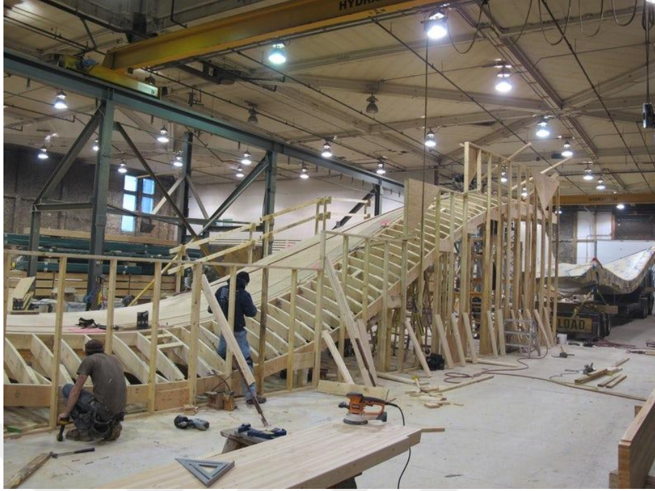
Şekil 4.35 Fabrika ortamında üretilen prefabrik çatı panelleri (Structure Craft, 2018)
