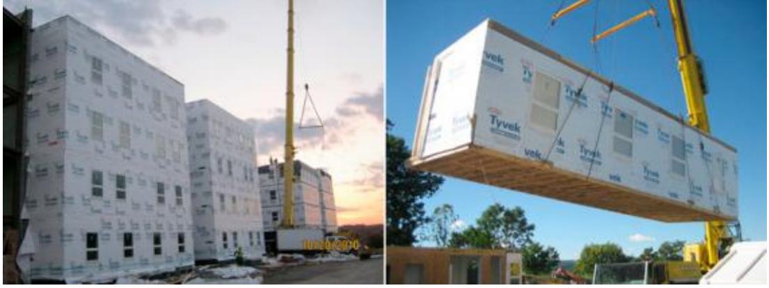
Şekil 4.22 Centennial Hall binası yapımında prefabrik modüllerin şantiye ortamında bir araya getirilmesi (Green, 2018)
