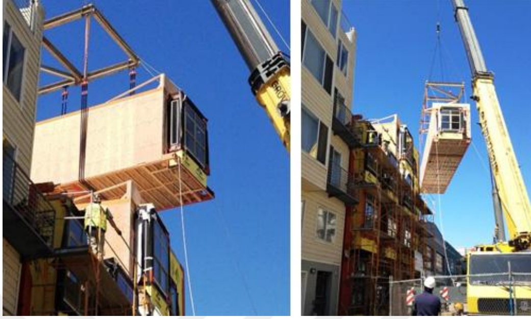
Şekil 4.12 SoMa modüler apartman binasında kullanılan modüllerin taşınması ve montaj işlemlerinin tamamlanması (Modular Building Institute, 2018)
