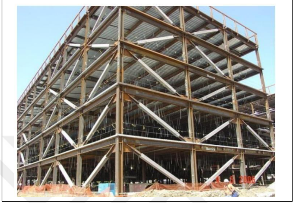
Şekil 2.6: Burkulması önlenmiş çaprazlı çelik çerçeve örneği.
