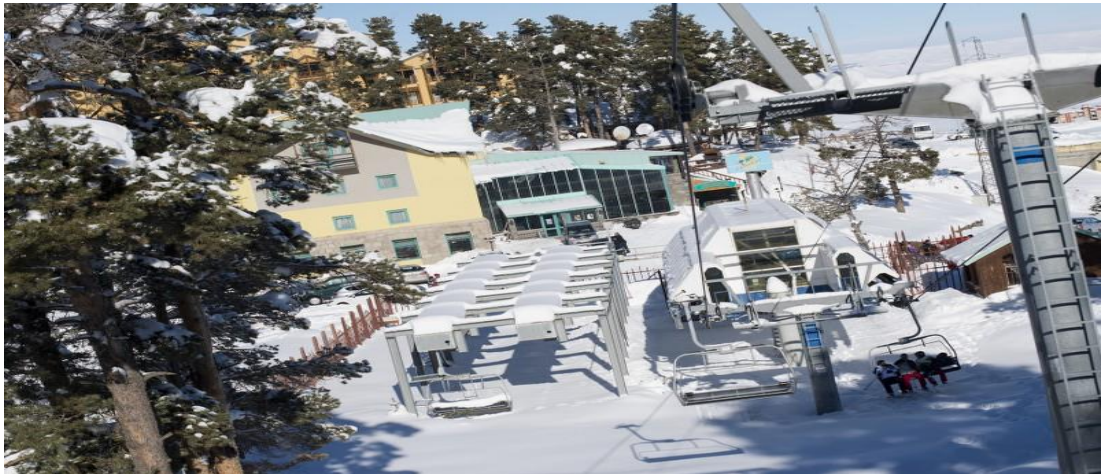
Fotoğraf 1.3. 1. Etap 1. Lift Sistemi
