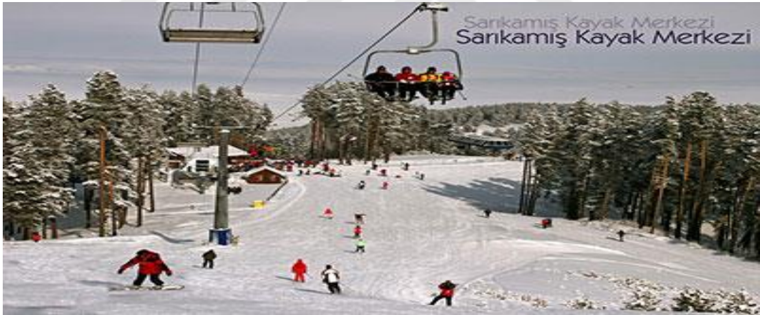
Fotoğraf 1.5. 2. Etap Lift Sistemi
