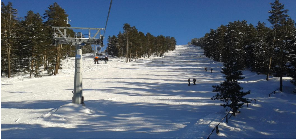
Fotoğraf 1.6. 3. Etap Lift Sistemi
