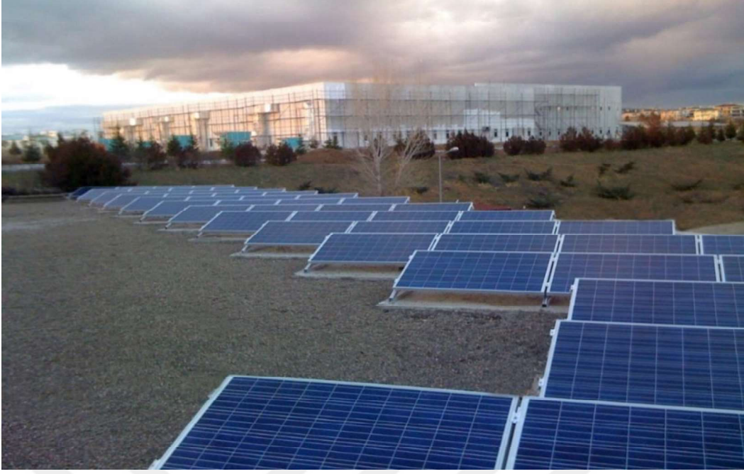
Şekil 3.26: Gölbaşı GES Çatı 2 Bölümü
