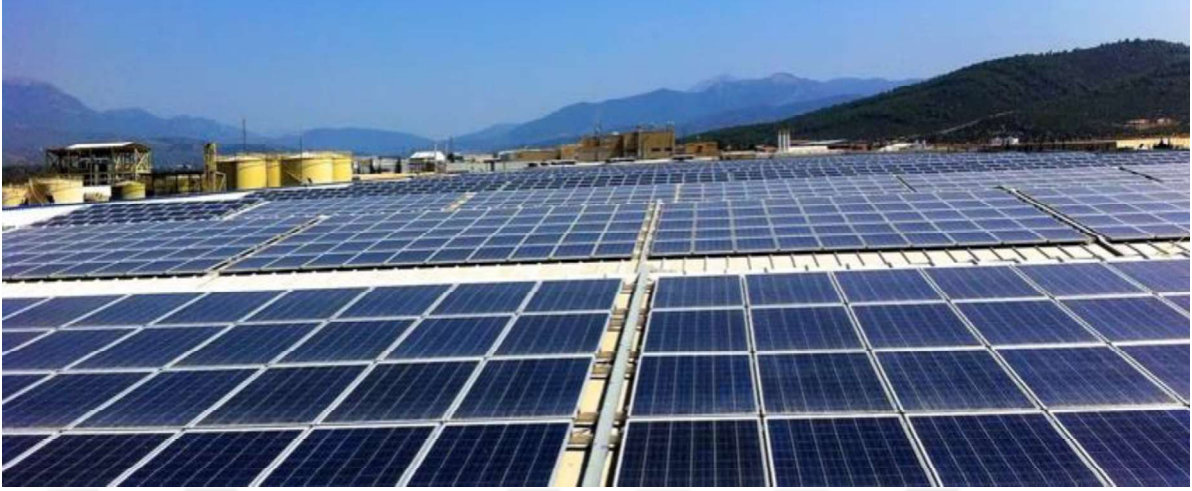
Şekil 3.2: Torbalı GES çatı görünümü
