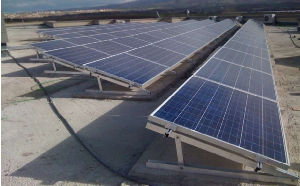
Şekil 3.25: Gölbaşı GES Çatı 1 Bölümü
