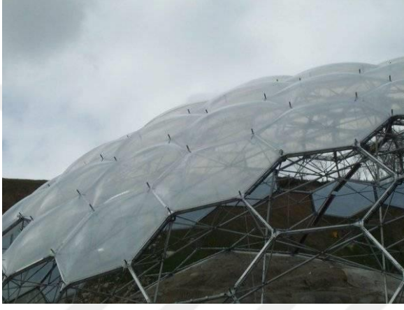
Şekil 4.54 Eden Projesi ETFE yastıkları ve çerçeveler (Url-72)
