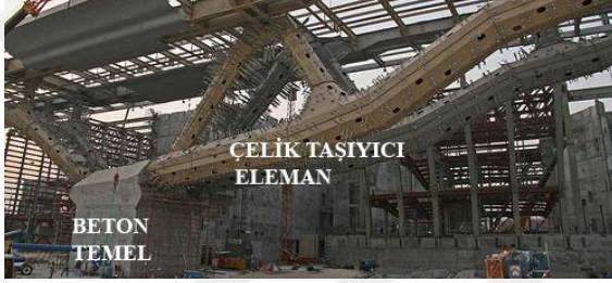
Şekil 4.14 Beton temel ve çelik taşıyıcı eleman (Url-31)
