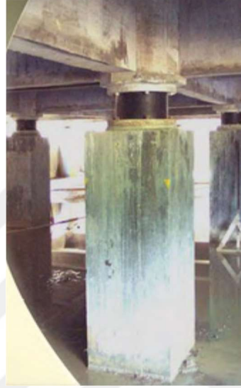
Şekil 1.3 Sismik izolasyon (deprem yalıtımı) uygulaması (Kaya, 2008)
