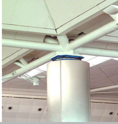
Şekil 2.11 Sürtünmeli sarkaç mesnet detayı, Atatürk hava limanının çatısı. (Earthquake Protection Systems Inc.b.t.)
