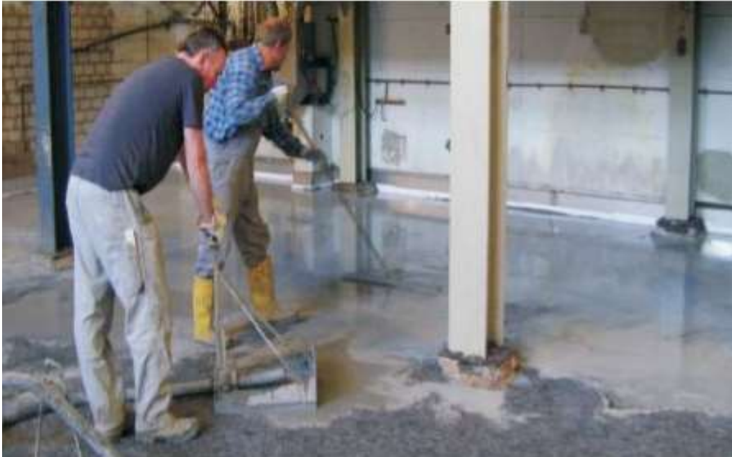
Fotoğraf 2.1. SIFCON'da bulamaç enjekte işleminin uygulaması
