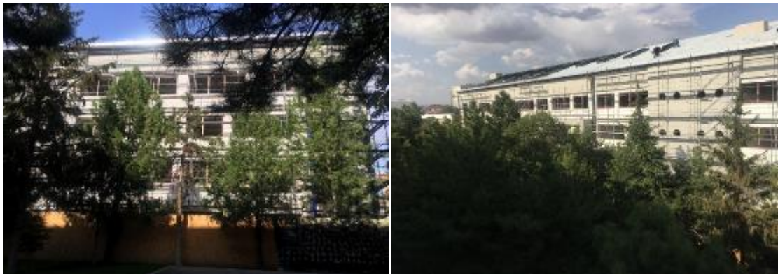
Şekil 5.93. TED Kayseri Koleji A blok anaokulu ve ortaokul inşası [178]
