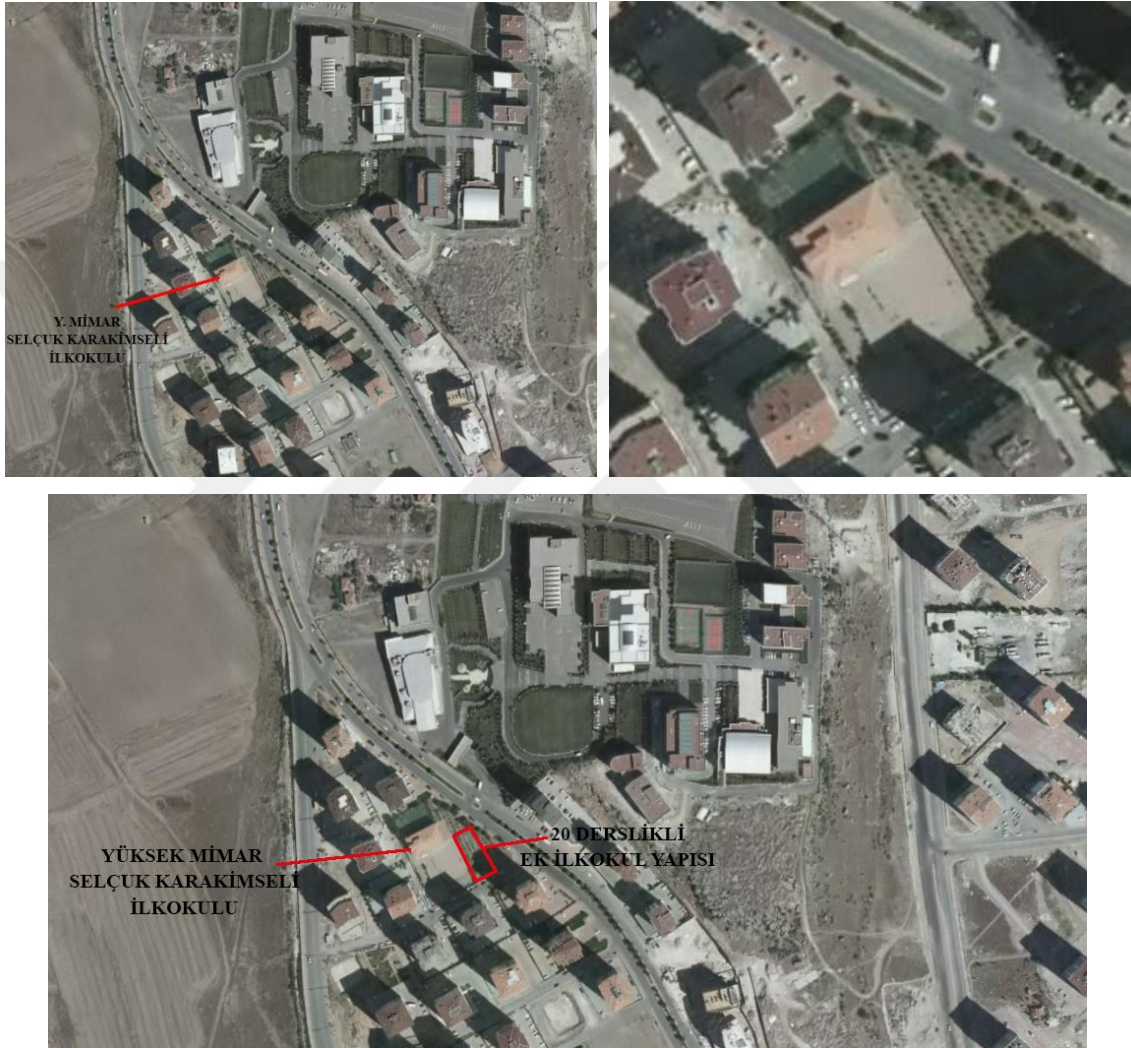
Şekil 5.27. Yüksek Mimar Selçuk Karakimseli İlkokulu uydu görüntüleri (sol üst mevcut ilkokul binası, sağ üst mevcut ilkokul binası yakın görünüşü, altta mevcut ve inşa edilmekte olan ilkokul binası)
