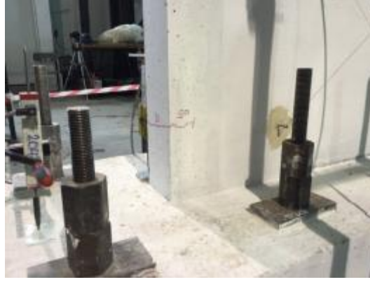
Şekil 5.18. Kolon elemanda meydana gelen ilk hasar (BÇN-4)
