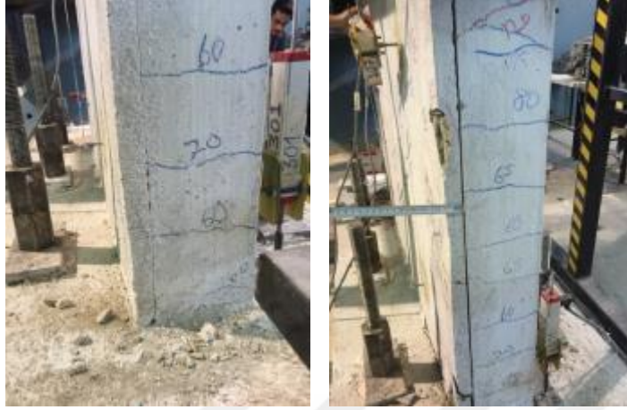
Şekil 5.48. Güçlendirme sıvası ile kolon ayrılması (BÇN-10)
