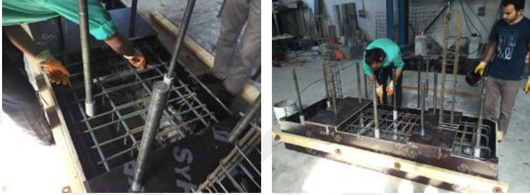
Şekil 4.3. Temelin beton dökümüne hazırlanması
