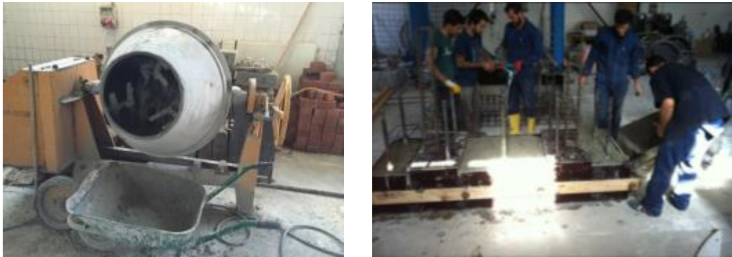
Şekil 4.4. Temel betonunun dökülmesi
