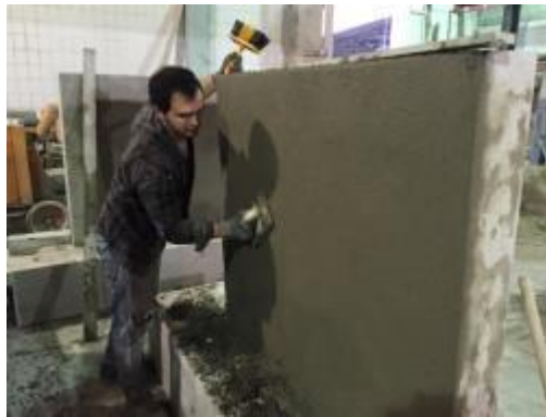
Şekil 4.10. Tuğla duvar üzerine sıva uygulamasının yapılması
