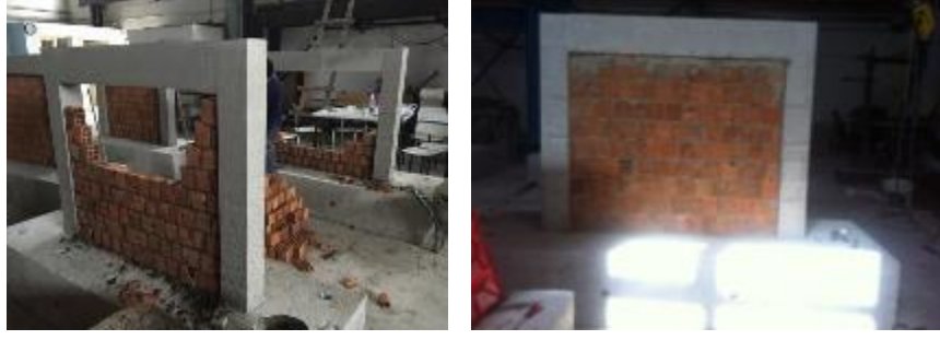
Şekil 4.8. Tuğla duvar örülmesi
