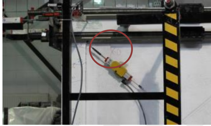
Şekil 5.12. Güçlendirilmiş duvar yüzünde ortaya çıkan ilk çatlak (BÇN-3)
