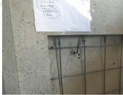
Şekil 4.21. Dolgu duvar üzerinde ankraj deliklerinin belirlenmesi
