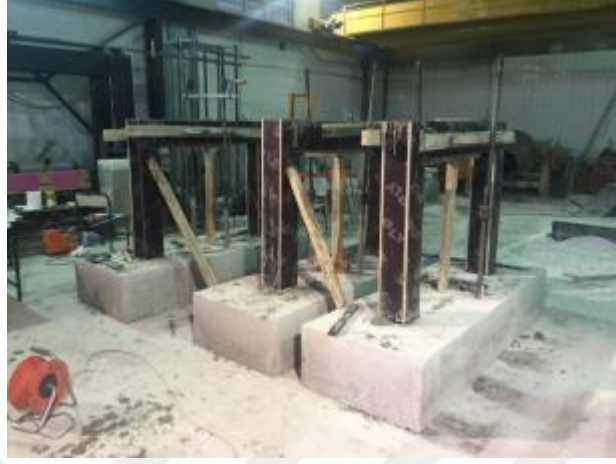
Şekil 4.5. Üst yapı kalıplarının hazırlanması
