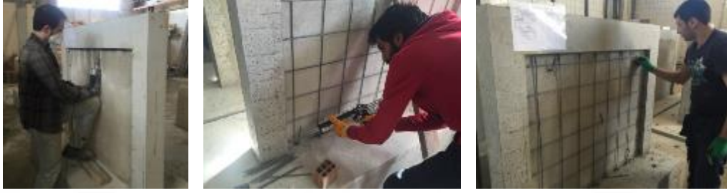
Şekil 4.20. Güçlendirme işleminin uygulanması aşamaları
