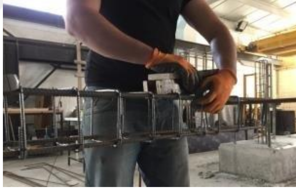
Şekil 4.2. Eleman donatılarının hazırlanması
