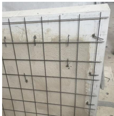
Şekil 4.29. BÇN-10'a ait ankraj görünümü
