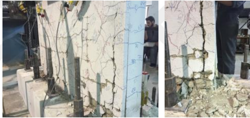
Şekil 5.62. Kolon boyunca meydana gelen çatlama (BÇN-11)
