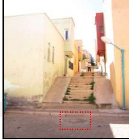
Şekil 4.191. Çalışma alanındaki teknik alt yapıya ilişkin örnekler
