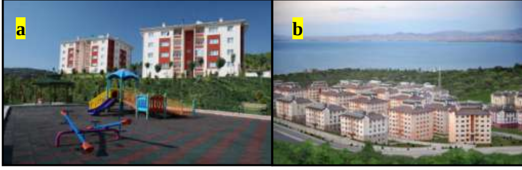
Şekil 3.26. Kütahya/Simav afet konutları (a) ve Van/Edremit afet konutları (b) (toki.gov.tr, 2017)
