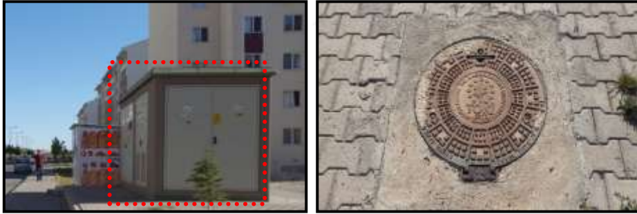
Şekil 4.18. Çalışma alanındaki teknik alt yapıya ilişkin örnekler
