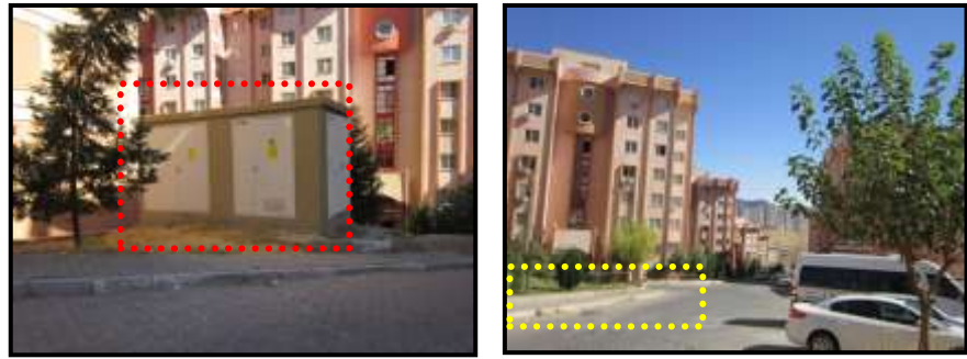
Şekil 4.76. Çalışma alanındaki teknik alt yapıya ilişkin örnekler
