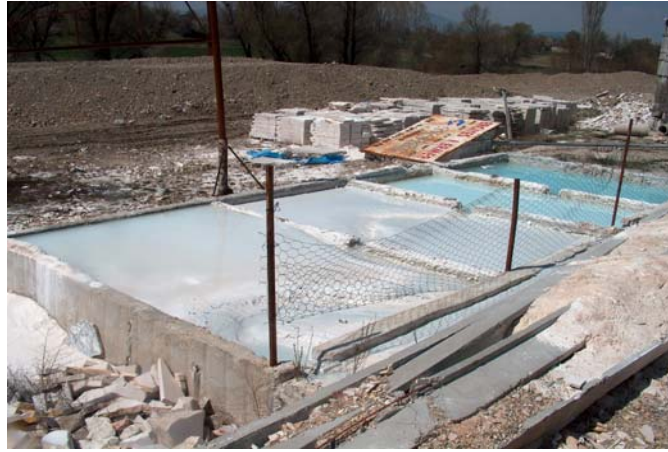
Şekil 2.28. Mermer işleme tesislerinde doğal çöktürme prosesi ile atıksu arıtımı
