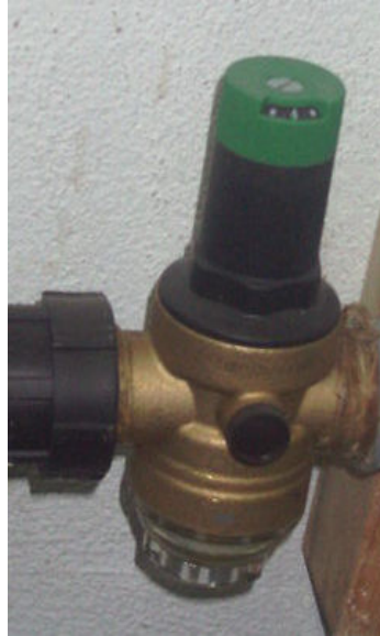
Resim 2.12. Şebekedeki basıncı düzenlemek amacıyla kullanılan basınç kırıcı
