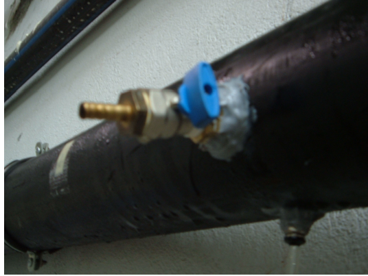
Resim 2.3. Numune alma musluğu (Boru başı)
