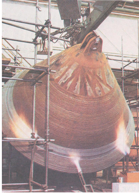
Şekil 7.22 Yüksek fırın kampanalarının dolgu kaynağı
