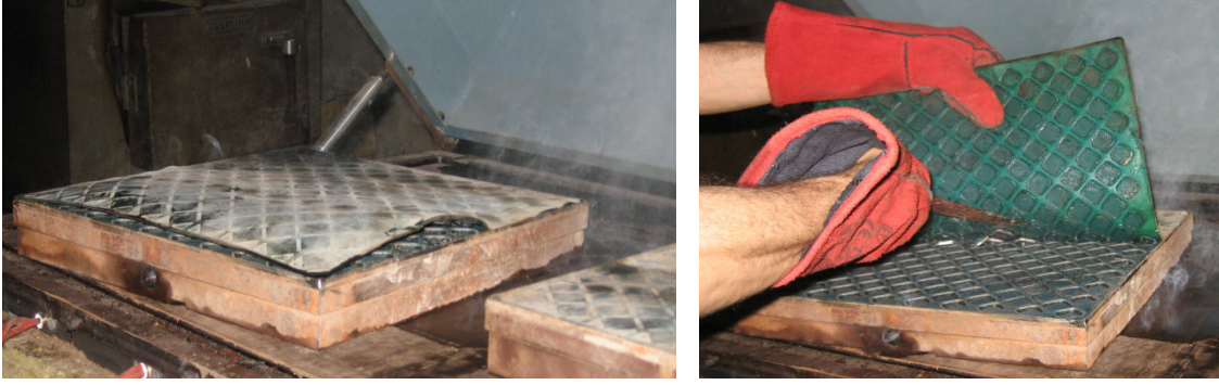
Şekil 10.11 Hasarlı kalıpların yüzeyindeki plastiklerin sökülmesi
