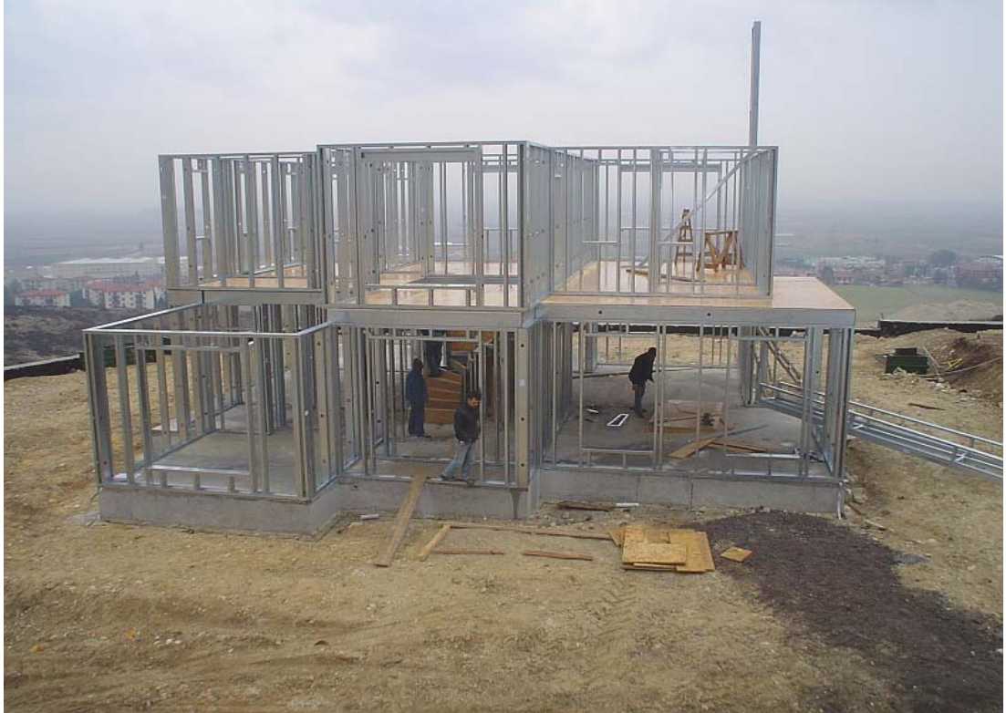
Şekil 5.9 Döşeme OSB'sinin kaplanması ve 1.kat duvarlarının dikilmesi - 6. gün
