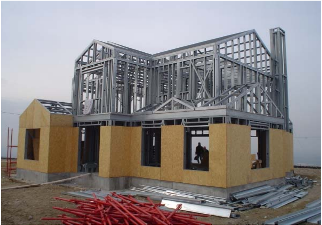
Şekil 5.17 Binanın dış cephe OSB-3 11 mm kaplamalarının yapılması (zemin kat duvarlarının kaplanmasından sonra iskele kurularak tüm cephe ve çatı kaplanacaktır)
