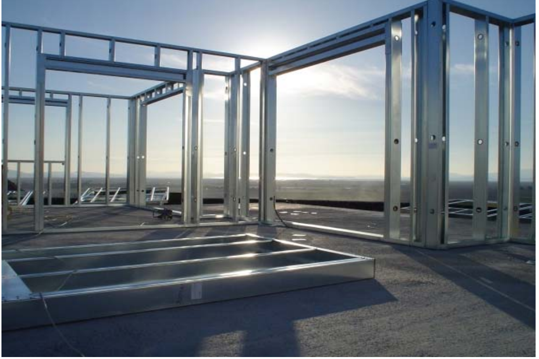
Şekil 5.6 Duvar panellerinin temel üzerine montajı (Atölyeden taşınan paneller, gönye ve şakül kontrolleri yapılarak 5,5 x 25 mm vidalarla birleştiriliyor) - 1.gün
