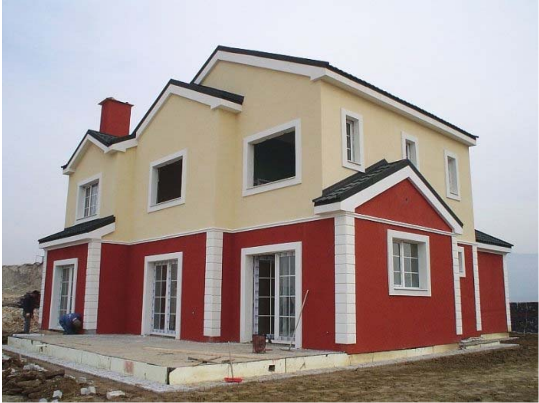
Şekil 5.21 Binaya dış cephe son kat uygulaması yapıldıktan sonra doğramaların takılması (ön cephe)
