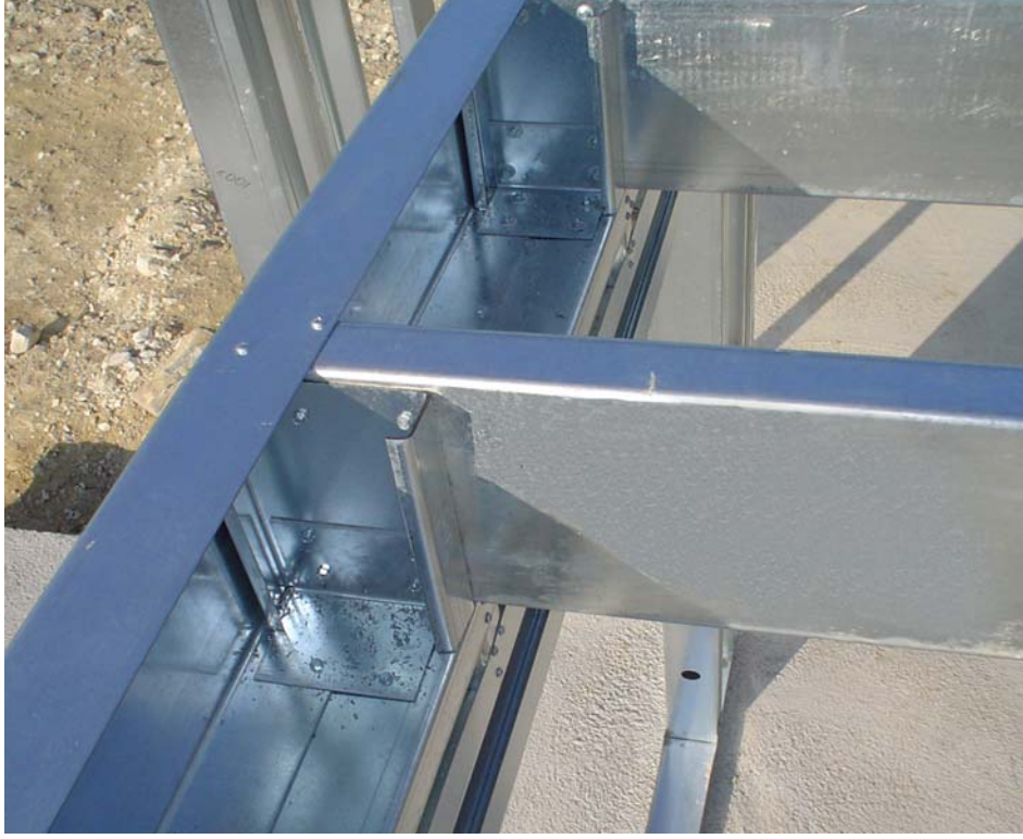
Şekil 5.8 Döşeme C kirişlerinin, döşeme U kapağına bağlantı noktasında berkitme profillerinin kullanılması (kısa C profil içine köşebent 10 adet 5,5x25 vida bağlantı)
