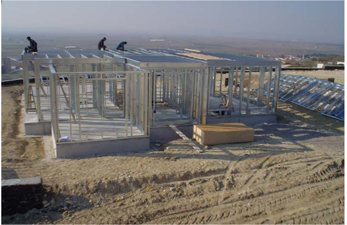
Şekil 5.7 Tamamlanan zemin kat duvarları üzerine döşeme kirişlerinin yerleştirilmesi - 2. gün
