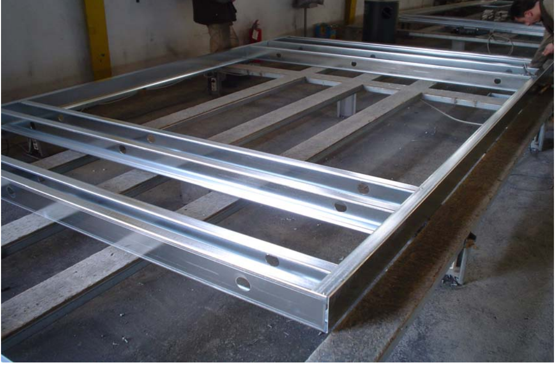
Şekil 5.2 Montaj sehpası üzerinde duvar paneli imalatı (alt ve üst başlık arasına kenar dikmeler vidalanıyor ve gönye kontrolü sonrasında ara dikmeler yerleştiriliyor)
