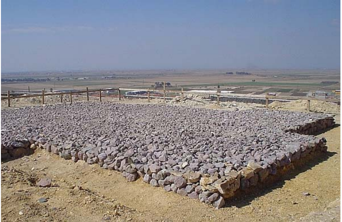
Şekil 5.3 Temelde kaya blokaj uygulaması
