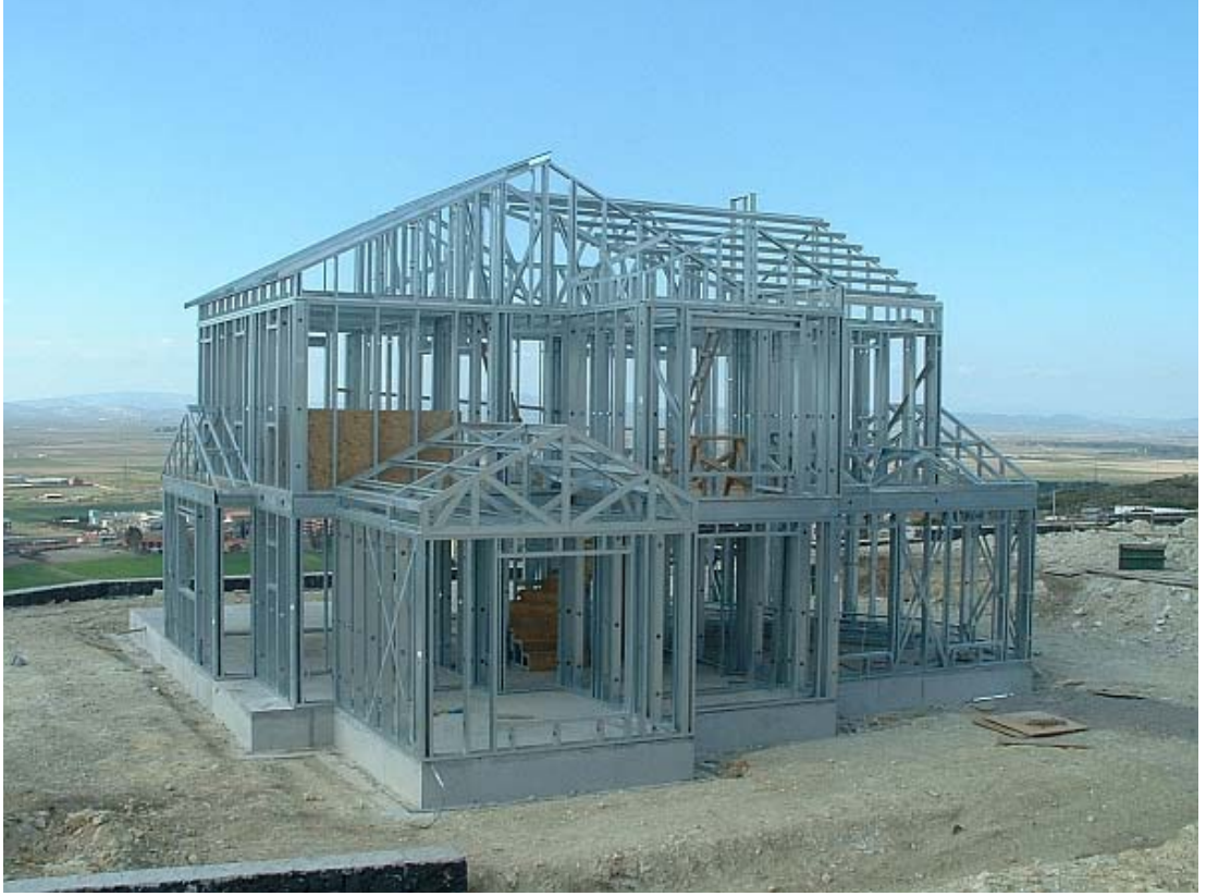
Şekil 5.12 Binanın çelik konstrüksiyonu bitirilmiş hali - 15. gün
