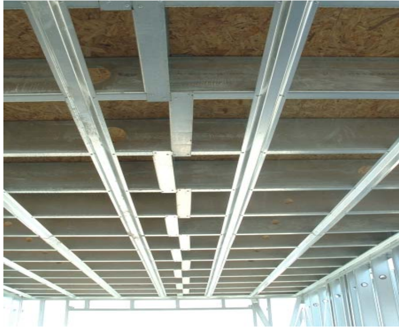
Şekil 5.15 +3.00 kotu döşemesinin alttan görünüşü (ortada döşeme kirişlerini bağlayan rijitleştirici - sold blocking uygulaması, kirişlerin altında yine rijitleştirici görevi gören alçıpan taşıyıcı omega profilleri, kirişlerin üstü OSB kaplı halde)
