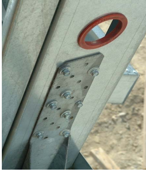
Şekil 5.14 8 adet 5,5 x 25 mm vidayla yapılan ankraj köşebenti bağlantısı ve üstte tesisat delik contası
