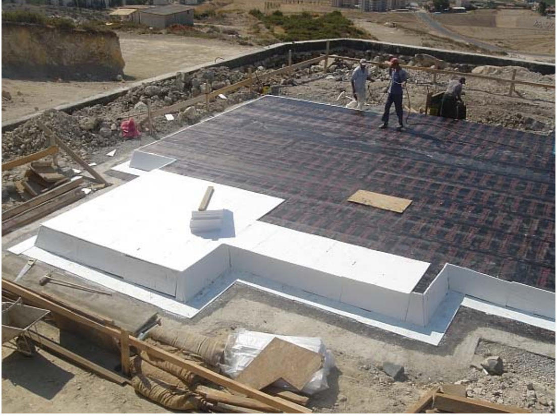
Şekil 5.4 Blokaj üzerine grobeton döküldükten sonra membran ile su yalıtımı ve sert köpük ile membran koruyucu tabaka oluşturulması, ısı yalıtımı yapılması
