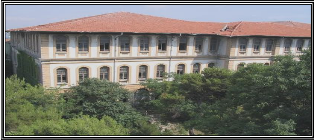
Ek-1 Tarihî Darüşşafaka Binası.
