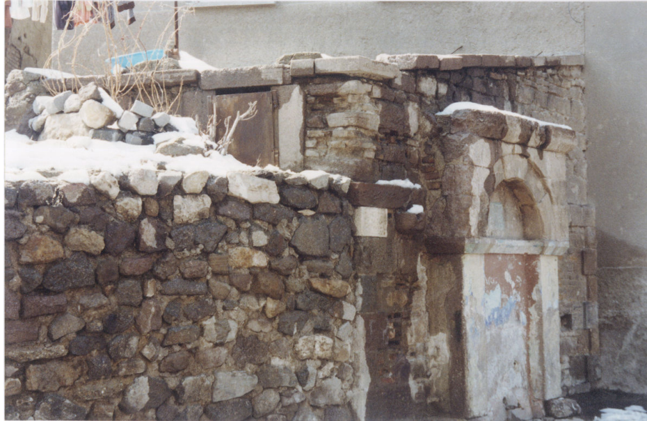
Resim No: 51 Hacı Nasuh Çeşmesi Yan Görünüş
