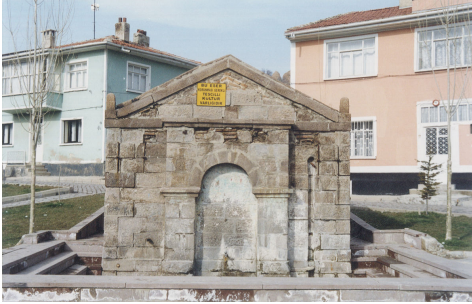
Resim No: 80 Yeni Çeşme Ön Görünüş
