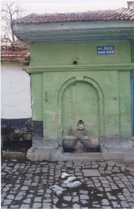
Resim No: 26 Kara Katip Çeşmesi Ön Görünüş
