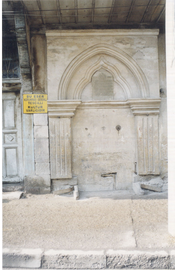
Resim No: 57 Sülüm 1 Çeşmesi Ön Görünüş
