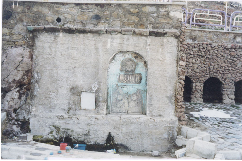
Resim No: 34 Taşpınar Çeşmesi Ön Görünüş
