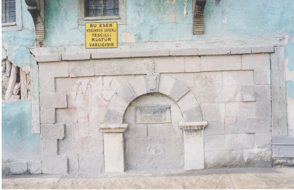
Resim No: 60 Sülüm 2 Çeşmesi Ön Görünüş
