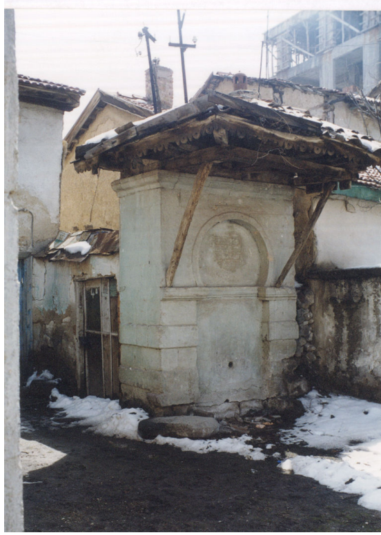
Resim No: 69 Boyacıođlu 1 Çeşmesi Yan Görünüő
