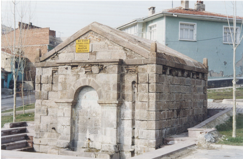
Resim No: 81 Yeni Çeşme Yan Görünüş
