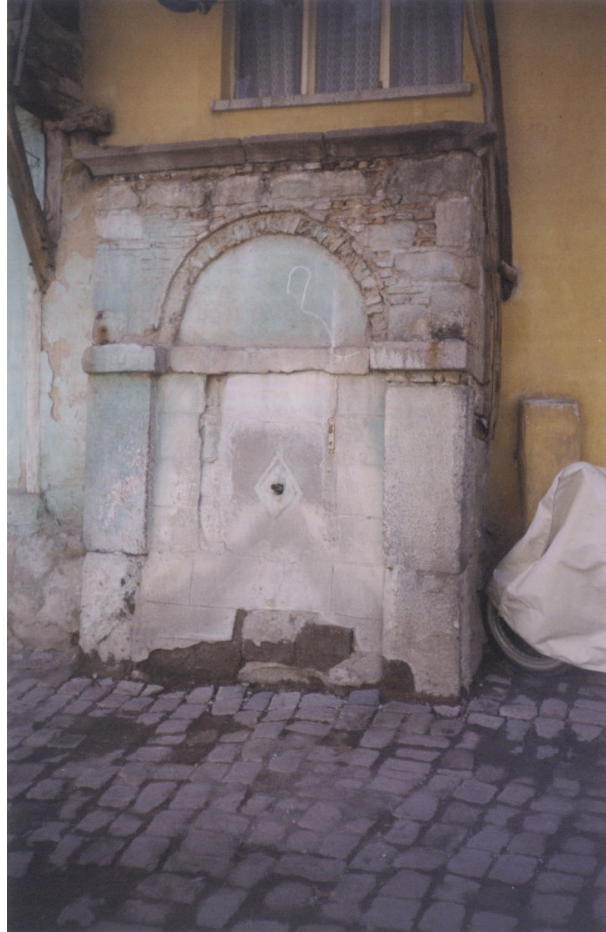
Resim No: 33 Bel Mescid eşmesi Ön Görünüş
