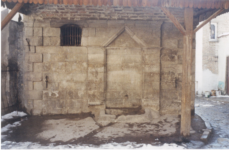
Resim No: 79 Hacı Aftal Çeşmesi Ön Görünüş
