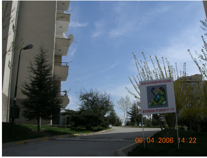
c.) Dilek 80 Sitesi giriş cephesi
