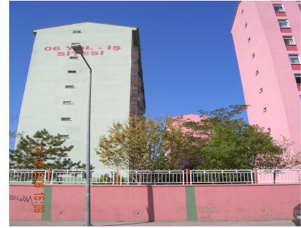
e. 06 Yol-İş Sitesi yol cephesi
